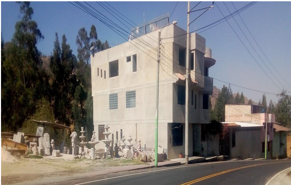
Fotografía 34 Viviendas hechas de material noble
