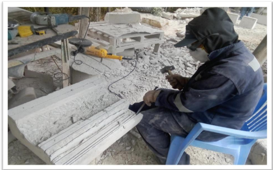
Fotografía 20 Trabajando la piedra manualmente
