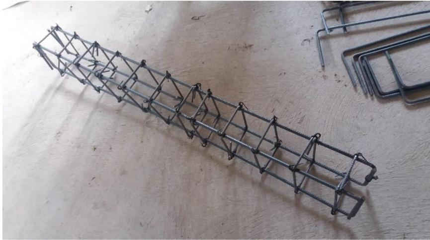
**Figura 7.23.** Armadura modelo de las vigas.
