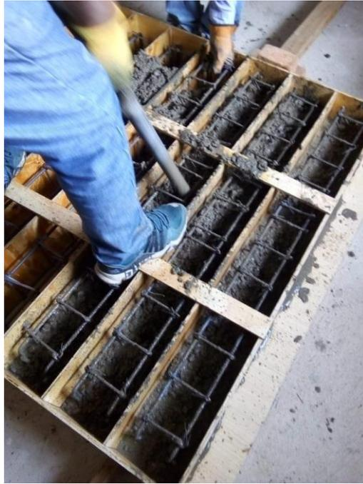
**Figura 7.25.** Vibrado del concreto en las vigas.
