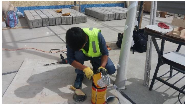
**Figura 7.33.** Vertimiento del componente A y B del adhesivo Sikadur-30.
