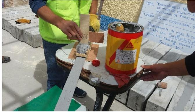
**Figura 7.36.** Aplicación del adhesivo Sikadur-30 a las láminas de Sika CarboDur S512.
