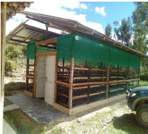
Figura 14 y 15. Planta de secado, para reducir la humedad tanto en coronta como en bráctea previamente picadas
