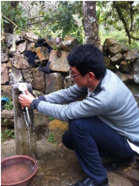
FOTO 35: Medición de presiones con manómetro en piletas domiciliarias
