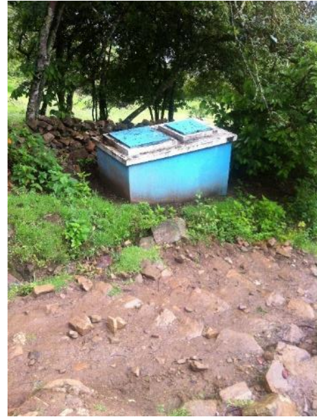
FOTO 24: Ubicación de la CRP-T7, N° 01
