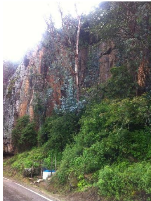
FOTO 4: Riesgo de derrumbes 2.
