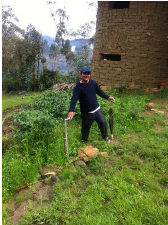
FOTO 25: Pileta malograda: sin grifo ni estructura de concreto
