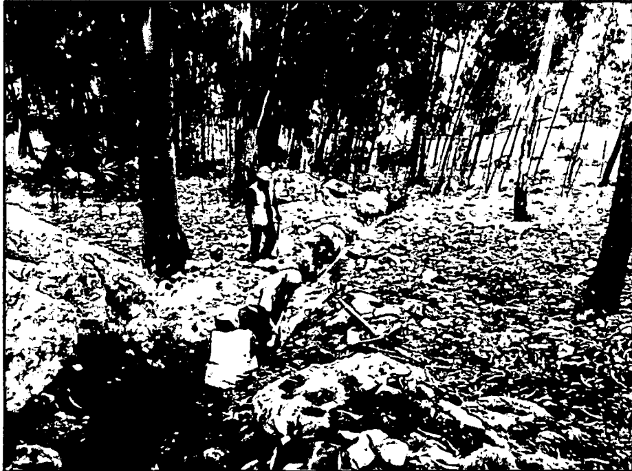
Figura No 05: Obreros realizando la excavación de zanjas.
