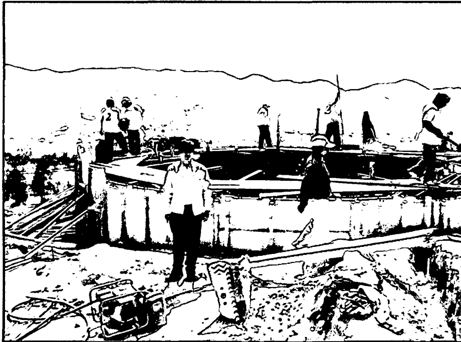
Figura No 08: Presencia el día en que se terminaba el encofrado – riego LLimbe.
