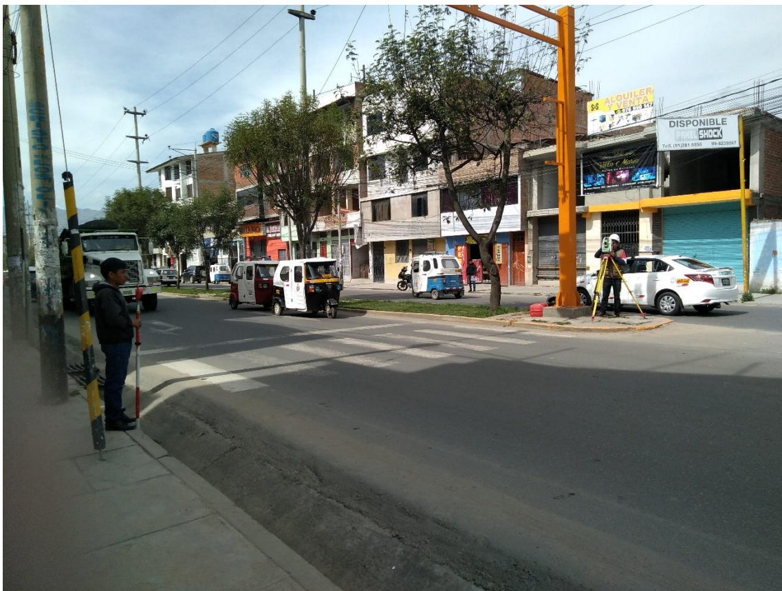
Figura 34: Levantamiento topográfico de la intersección semaforizada.
