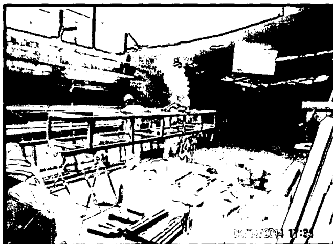
Figura 29: Soldeo de perfil cuadrado 2"x2"x3mm de sección 0,80m x 0,40m x 9,00m
