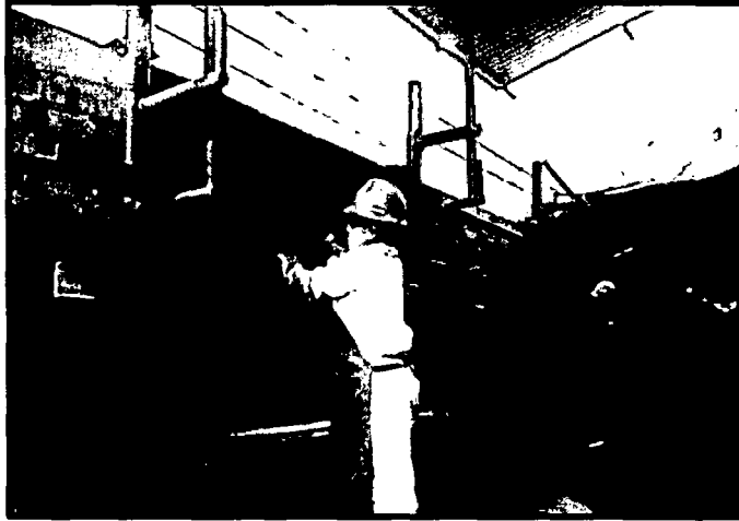
Figura 12: Producción de Bidas -Traslado de perfil angular 2"x2"x1/4 de sección 0,80m x 0,40m
