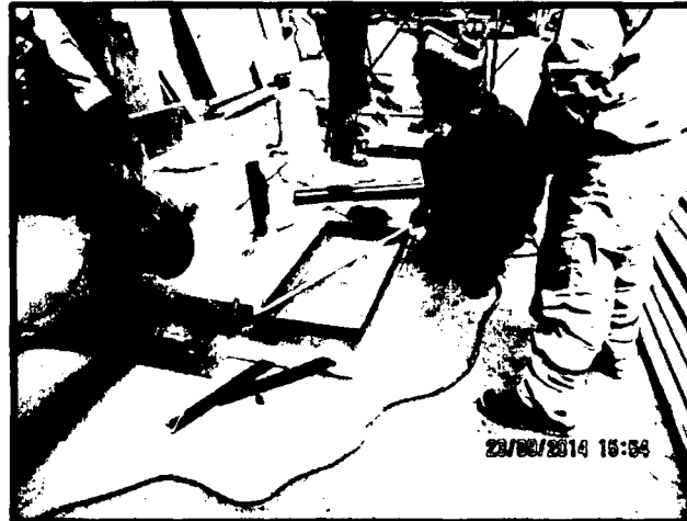
Figura 15: Producción de Bidas - Nivelación de perfil angular 2"x2"x1/4 de sección 0,80m x 0,40m
