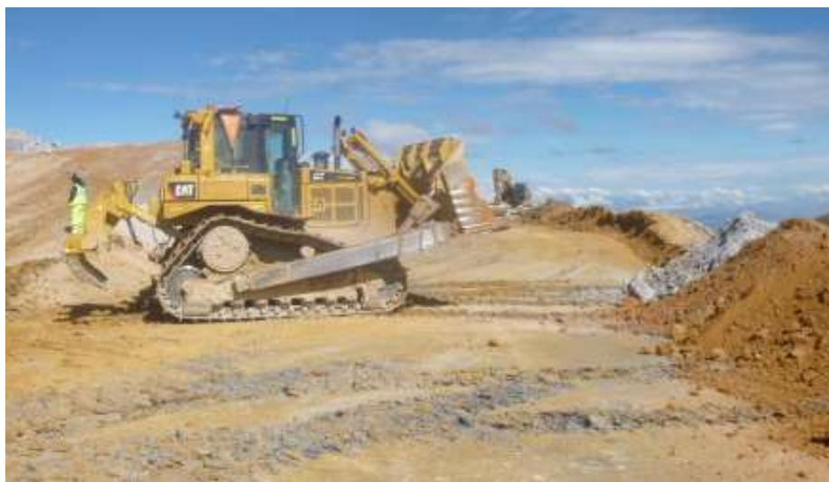
Foto 5. Tractor CAT D6 empujando desmonte en el DME
