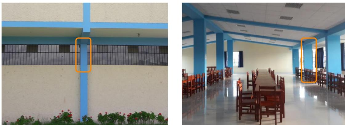
La rigidez de la columna corta y total se calculó utilizando la ecuación (2.10); el momento de inercia se la sección en cada dirección de análisis se determinó de acuerdo con la ecuación (2.11) y el módulo de elasticidad del concreto con la ecuación (2.12).
