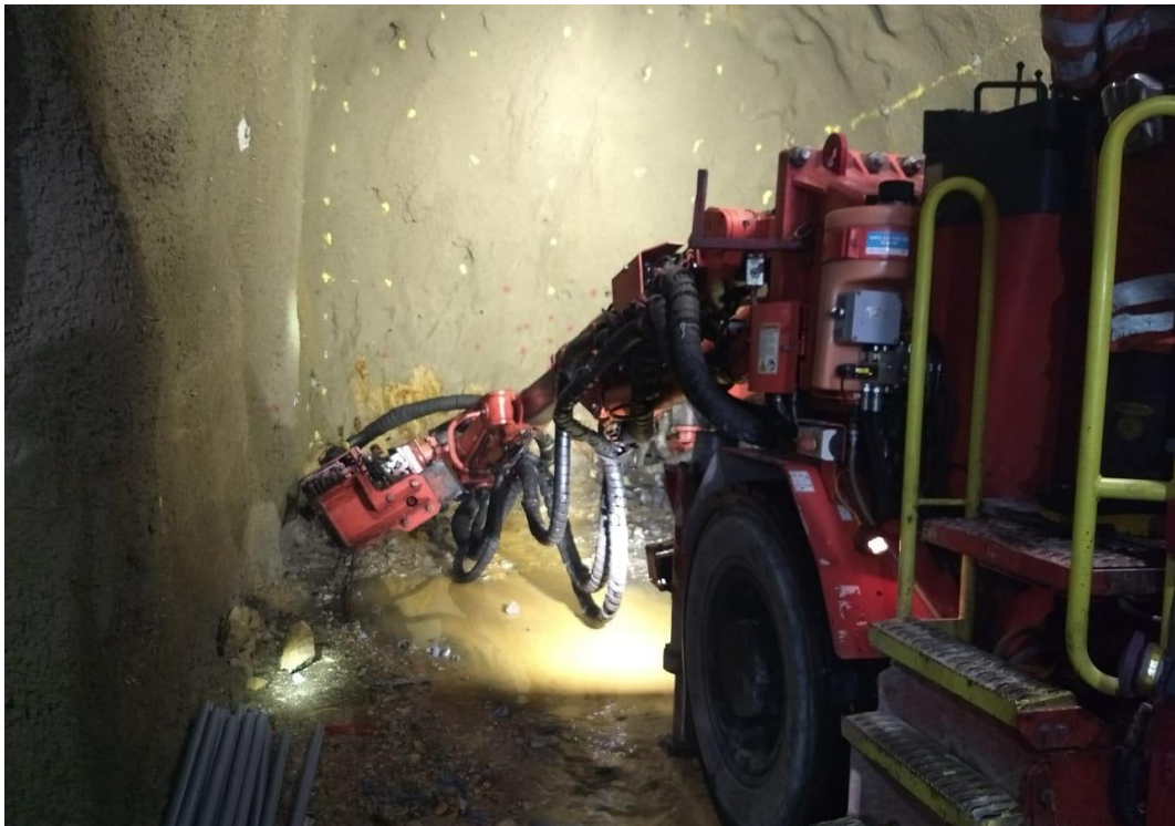
Foto 3. Perforación del frente con Jumbo Sandvik DD 321.
