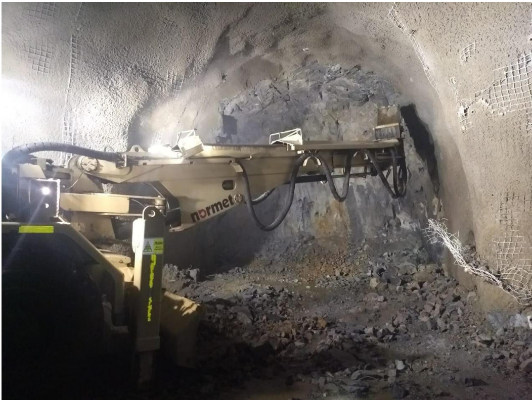
Foto 4. Desatado de rocas con equipo mecanizado Scaler Normet Scamec 2000.
