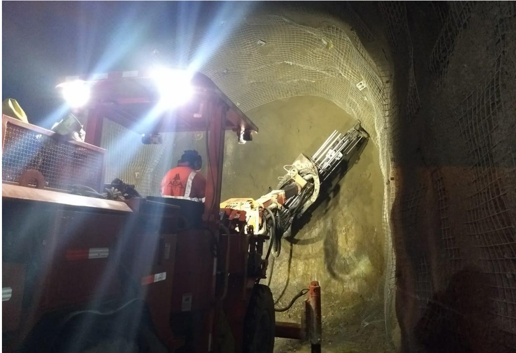
Foto 5. Sostenimiento mecanizado con Bolter Sandvik DS311.
