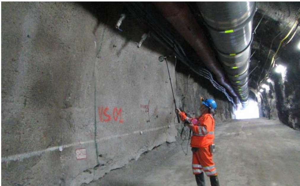
Foto 11. Medición de caudal de aire con anemómetro TESTO 480.
