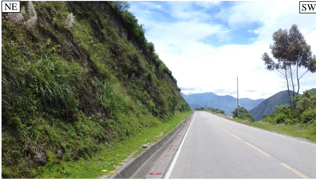
Foto 3. Talud en el tramo 03, Km.148+400 – Km.148+600.
