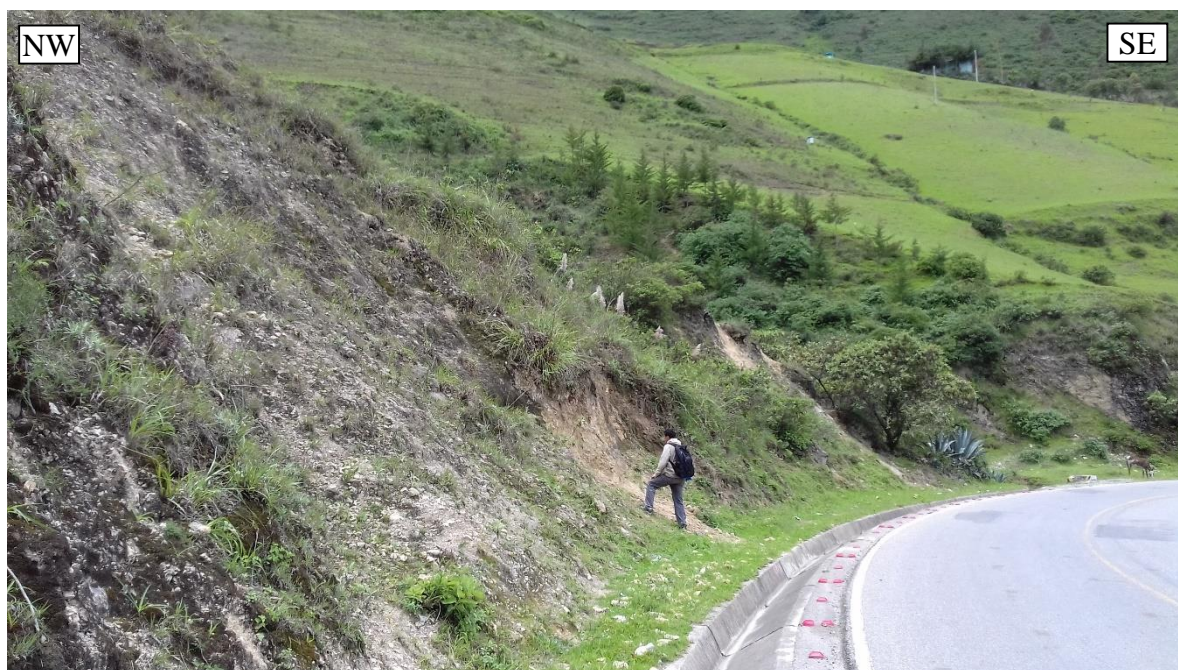
Foto 2. Talud en el tramo 02, Km. 149+280 – Km.149+330.
