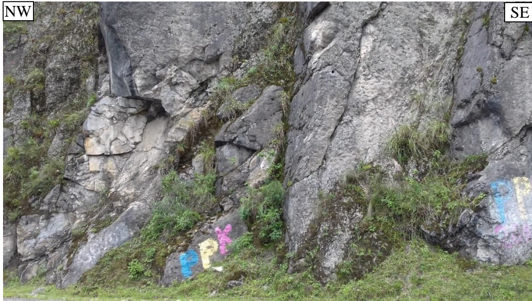
Foto 4. Talud en el tramo 04, Km.148+110 – Km.148+160
