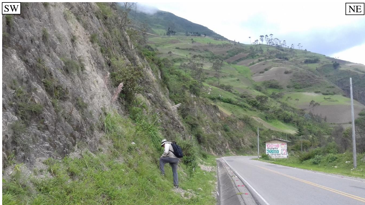
Foto 5. Talud en el tramo 05, Km.146+500 – Km.146+650
