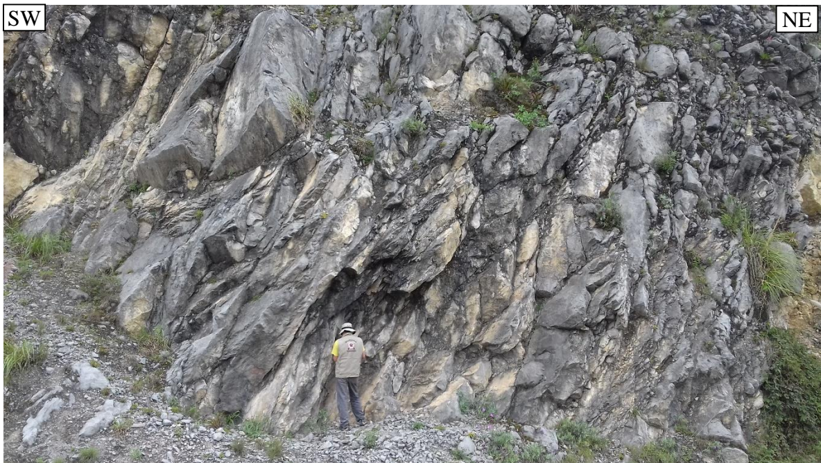
Foto 7. Talud en el tramo 07, Km.145+570 – Km.145+620.
