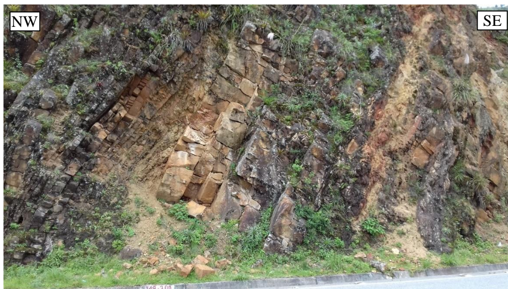
Foto 1. Talud en el tramo 01, Km. 149+670 – Km. 149+720
