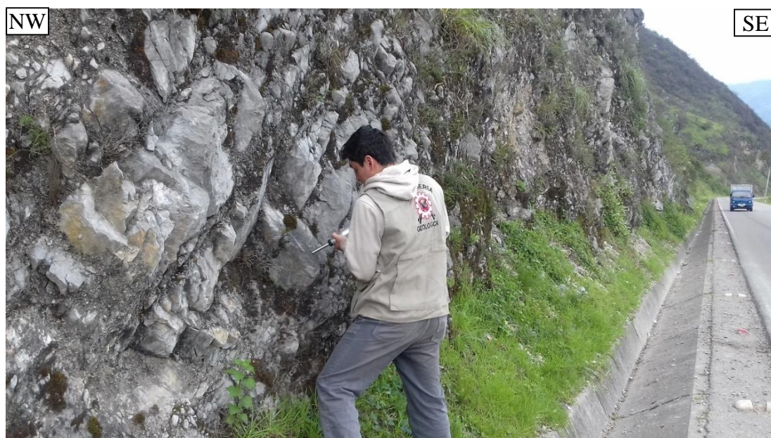
Foto 6. Talud en el tramo 06, Km.146+200 – Km.146+280.
