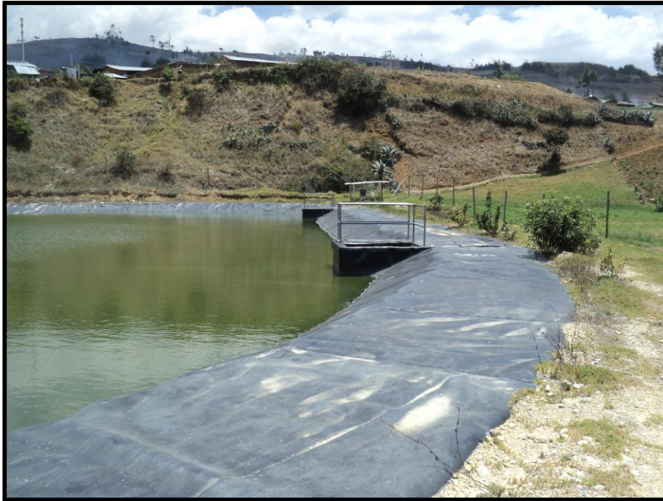
Anexo 39: Salida de agua tratada al punto efluente.
