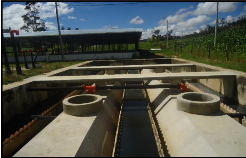
Anexo 33: Efluente clarificado y canaletas de afluencia.
