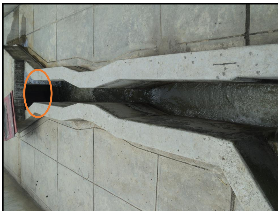
Anexo 27: Salida del agua residual a desarenadores.
