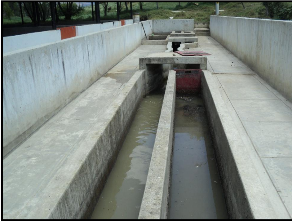
Anexo 29: Colocación de baffle de madera para limpieza de desarenador
