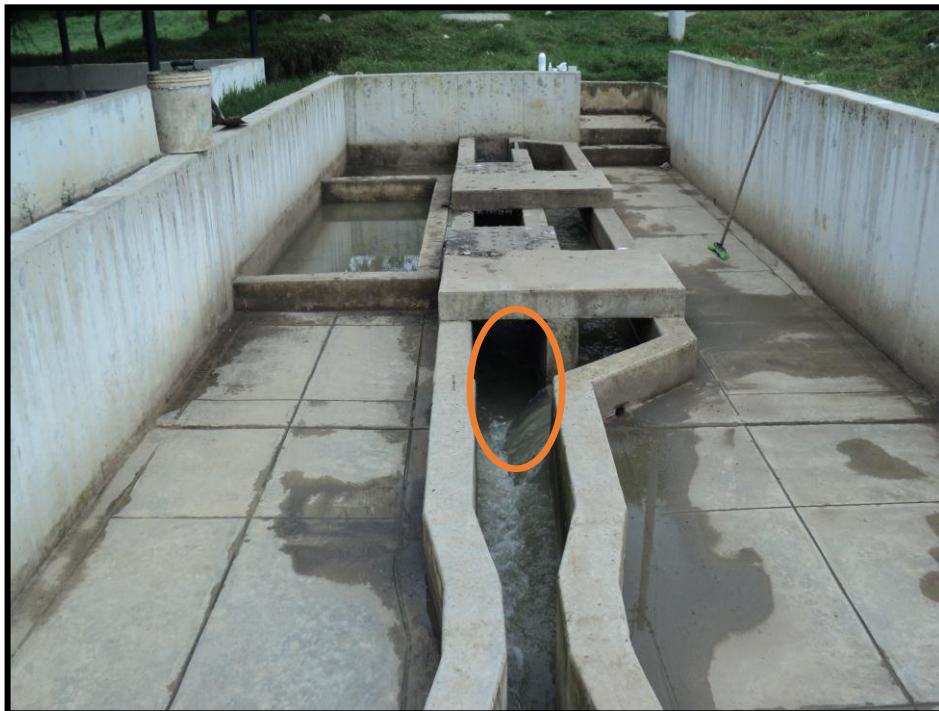
Anexo 27: Salida del agua residual a desarenadores.
