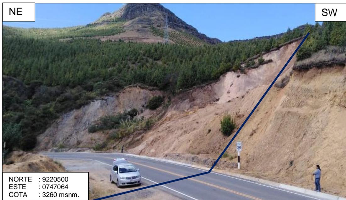
Foto 08. Talud conformado por limos arcillosos, en la progresiva 52+000.
