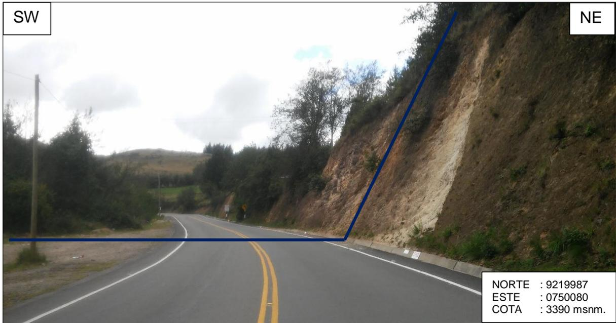
Foto 13. Talud por compuesto por dacita en la progresiva 51+500.
