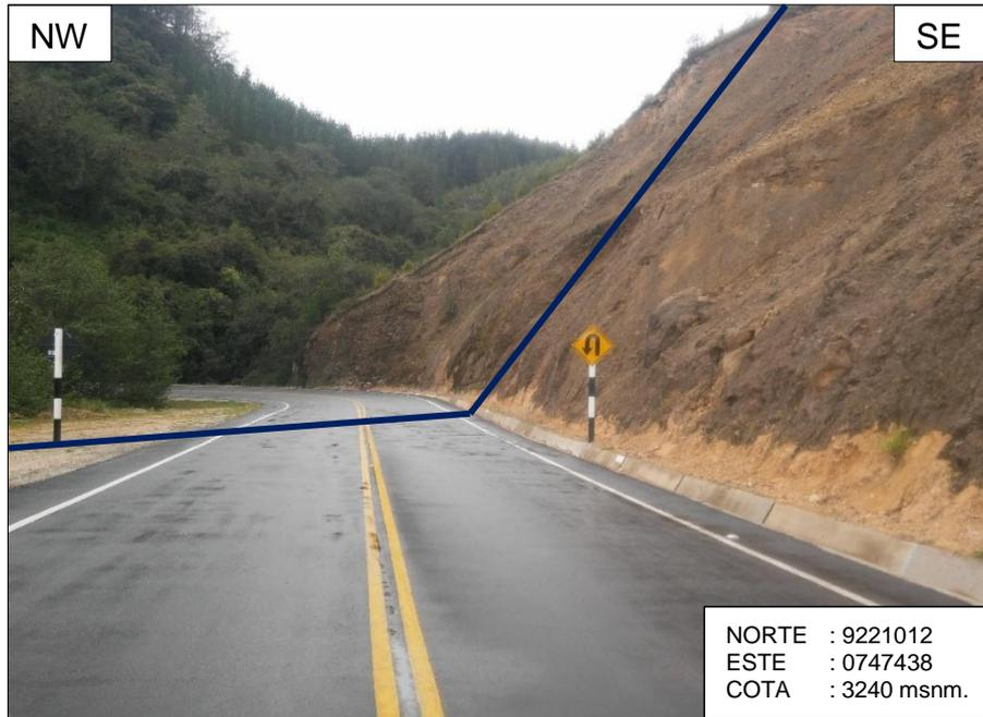
Foto 09. Talud conformado por dacita fracturada en la progresiva 45+500.
