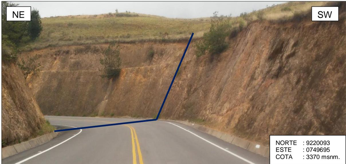
Foto 12. Talud constituido por suelo, en la progresiva 50+100.
