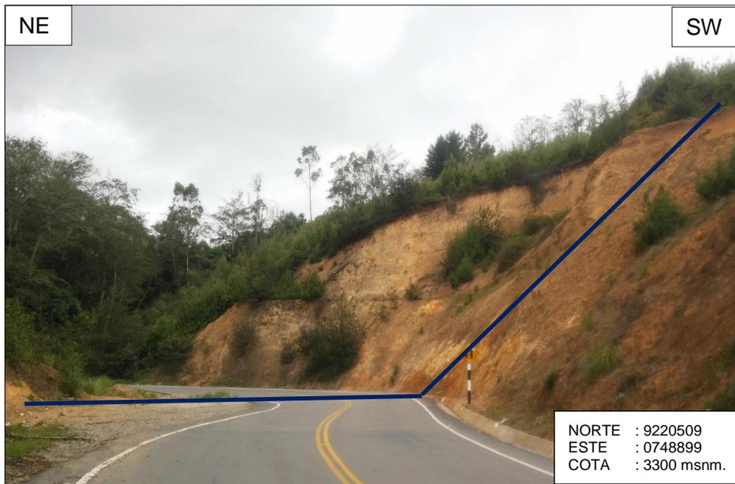
Foto 11. Talud altamente erosionado en la progresiva 48+700.
