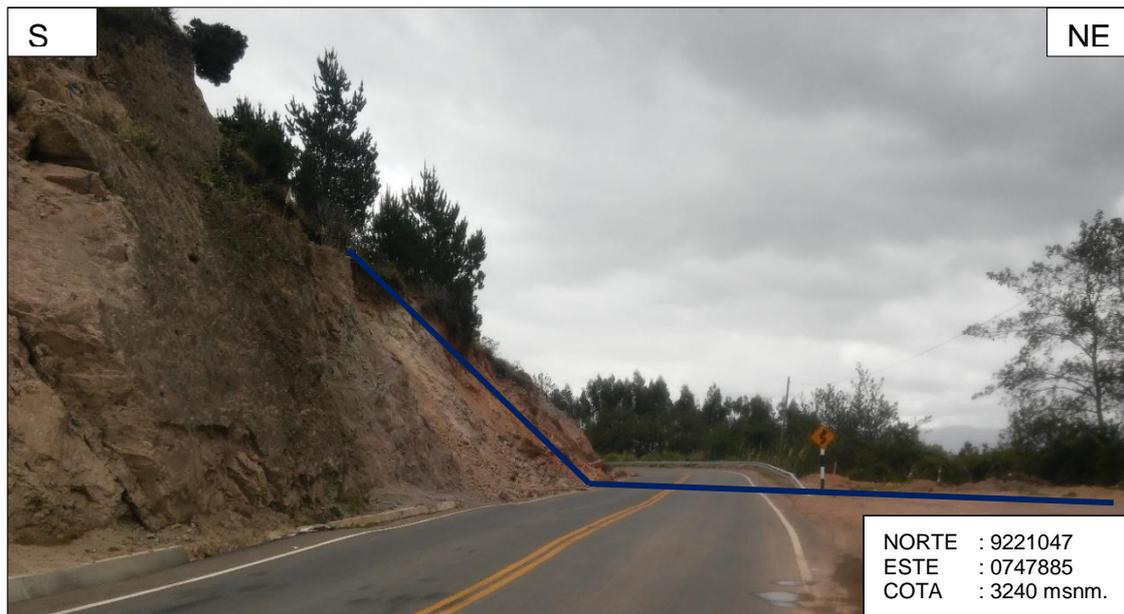
Foto 10. Talud altamente erosionado y fracturado en la progresiva 46+900.
