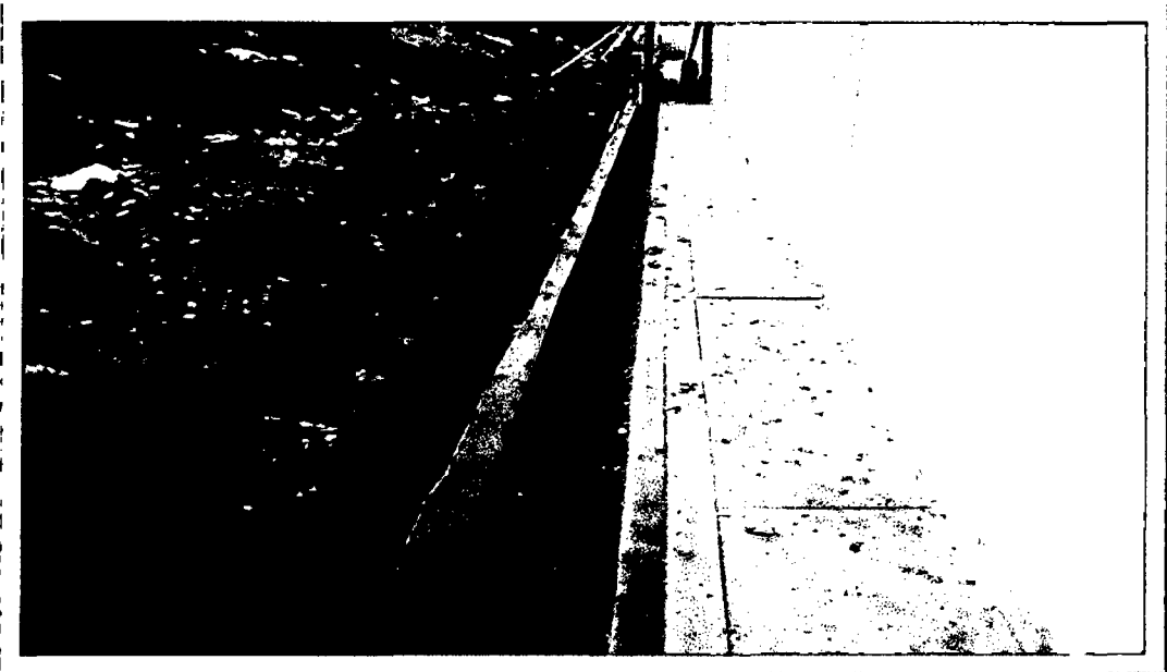
Trabajos adicionales - Canaleta parte posterior de aulas.
