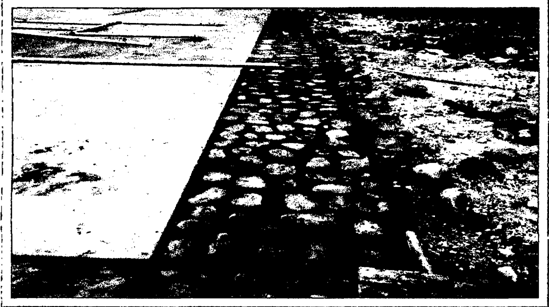
Trabajos adicionales - Mampostería de Losa Deportiva
