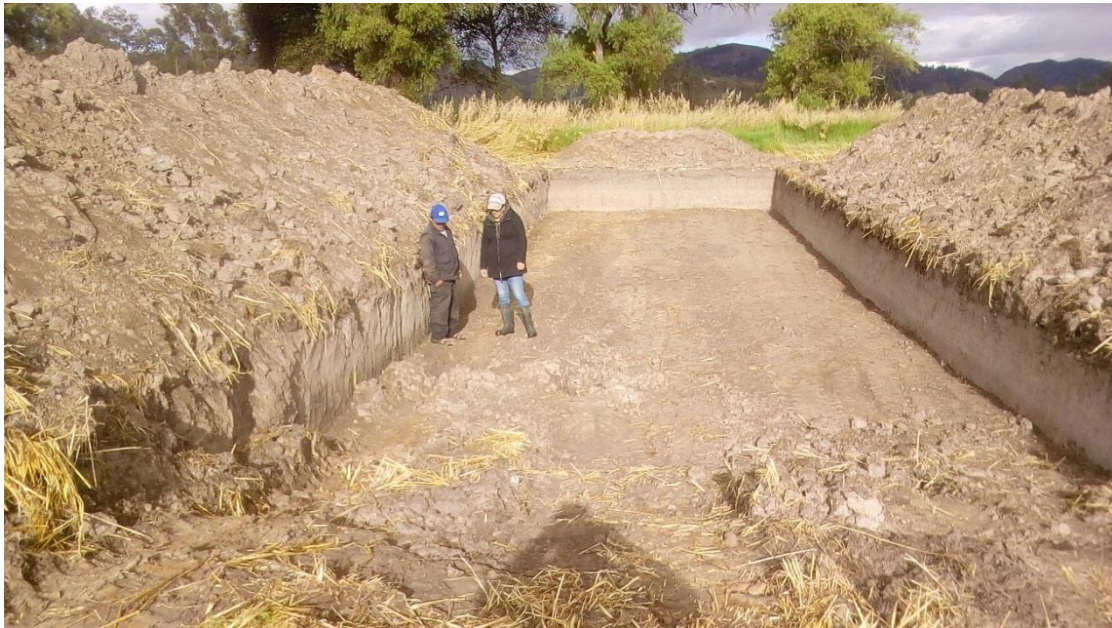
Fotografía N° 11. Excavado para silo trinchera.
