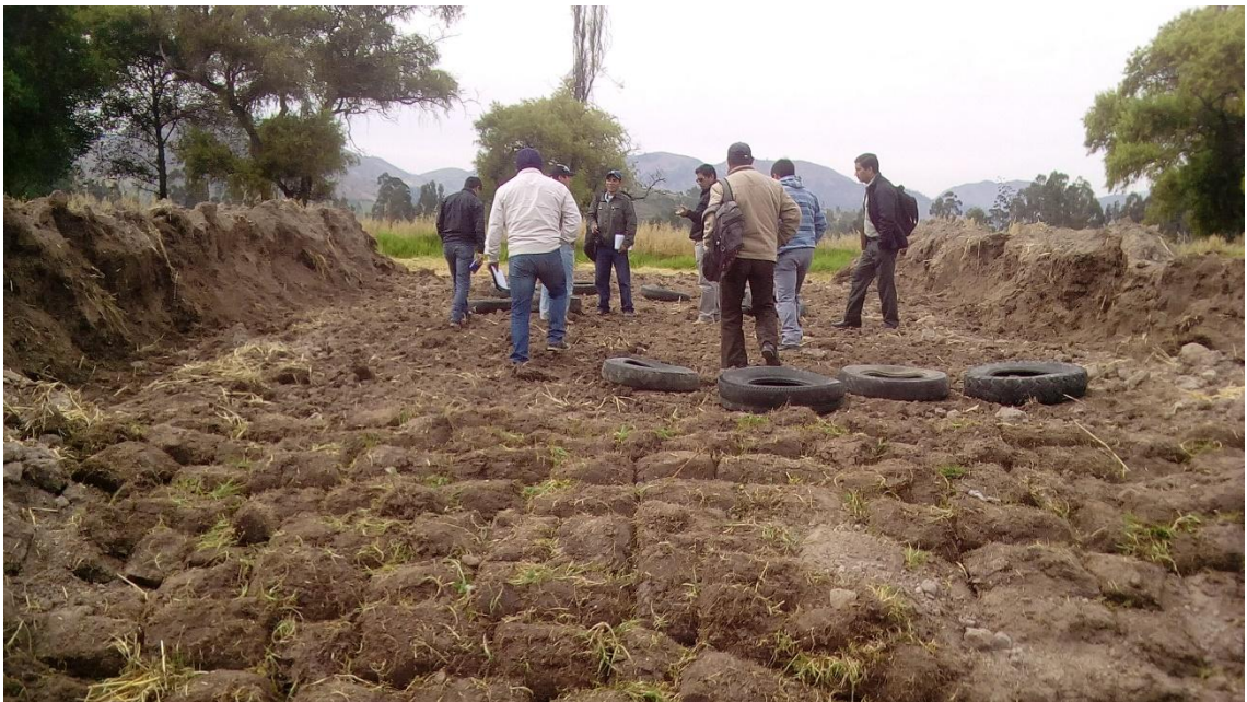
Fotografía N°15. Tapado del silo
