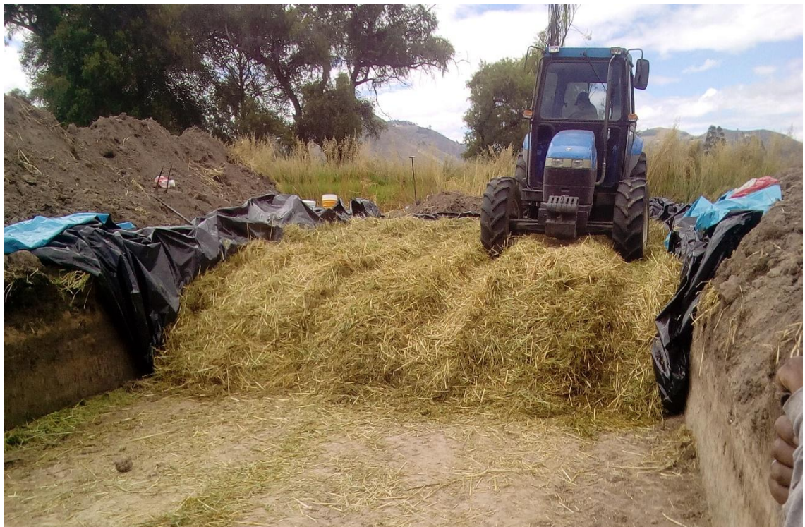
Fotografía N° 13. Compactación con tractor
