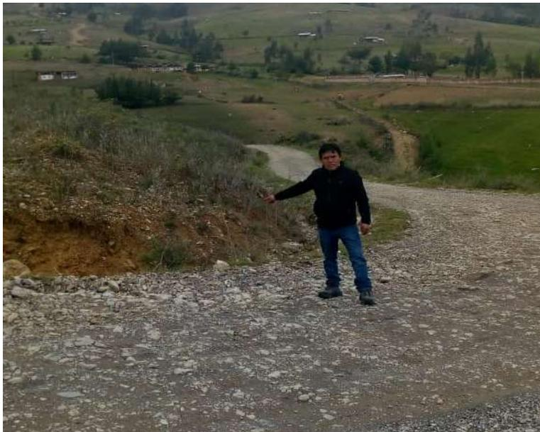
Km. 5+040, inicio de curva, la cual no cuenta con el radio mínimo, por no contar con cunetas, las aguas de lluvia generan su propio cause malogrando el ancho de la carretera y el talud del terreno natural.
