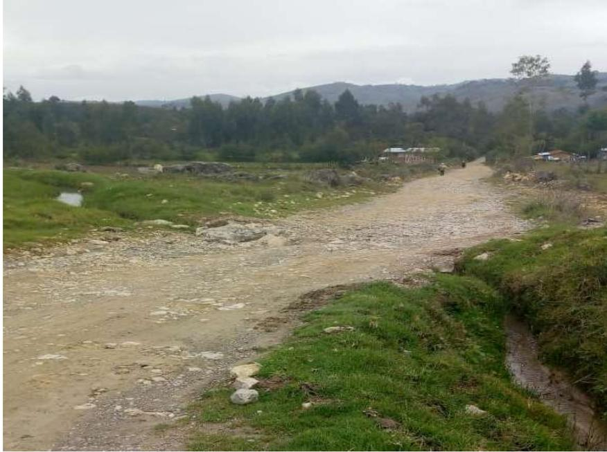
Tramo de la carretera en el km. 3+450, se tiene un pase de agua de regadío, el cual está construido de mampostería de piedra en malas condiciones, lo recomendable es tener una alcantarilla de concreto o TMC
