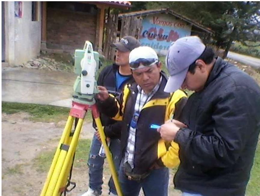
Toma de datos del levantamiento topográfico utilizando una estación total, marca leica TS02
