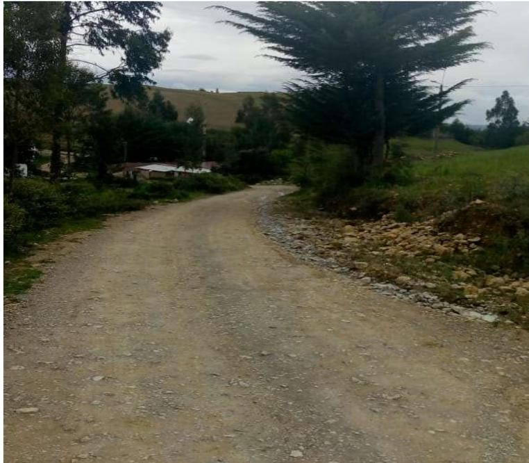
Km. 4+550, ancho de la carretera variable y sin cunetas, donde las aguas de lluvias han realizado su propio cause malogrando el ancho de la vía
