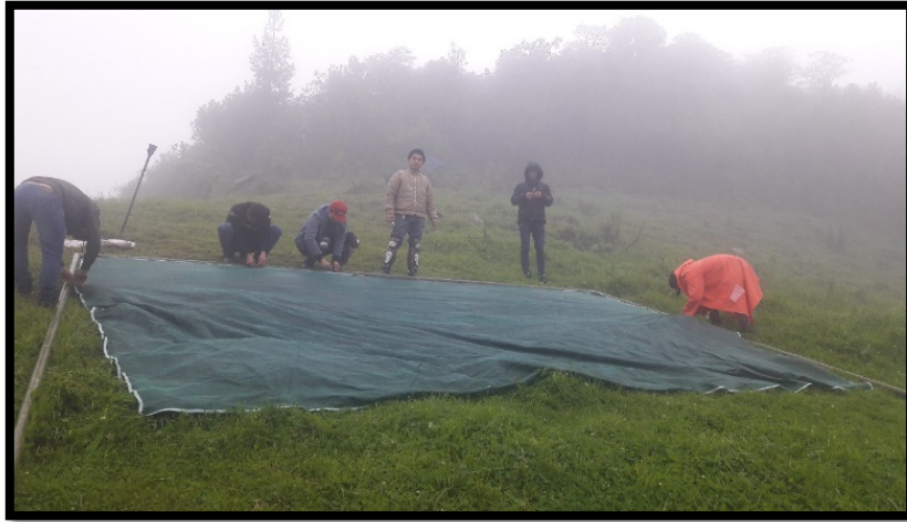
Figura N°16. Armado de la malla raschel en los parantes metálicos.
