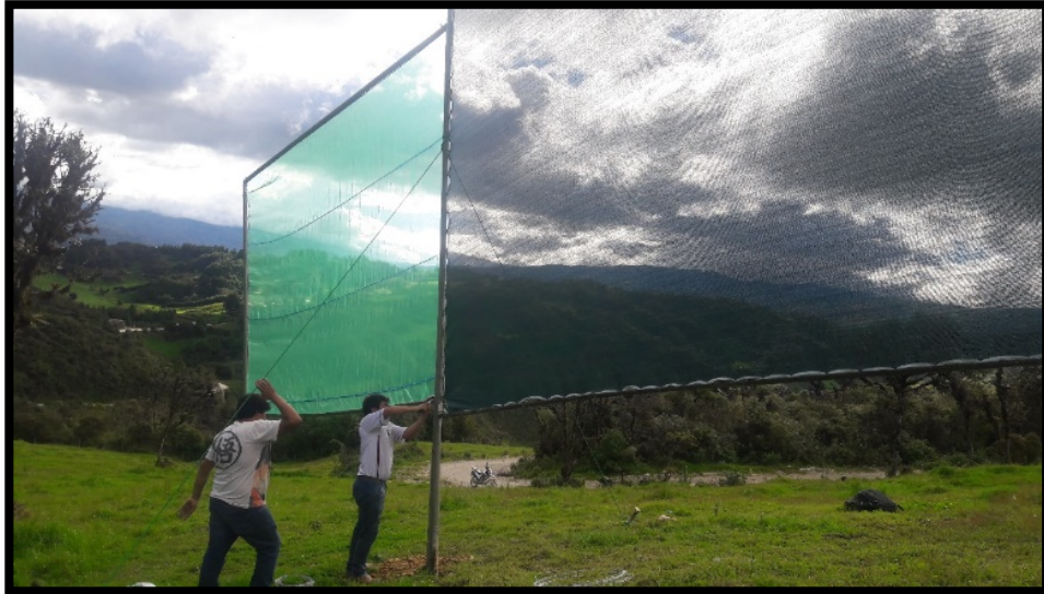
Figura N°18. Malla Mosquitero a la izquierda y Malla raschel a la derecha. Proceso de fijación y colocación de manguera en canaleta.
