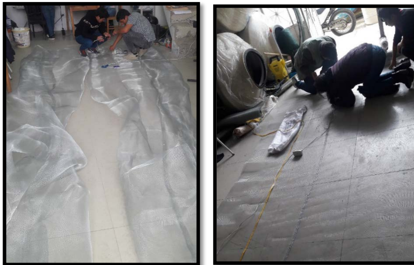
Figura N°17. Proceso de unión de franjas de malla metálica.
