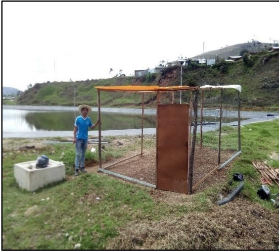
Figura 18. Construcción de la caseta.
