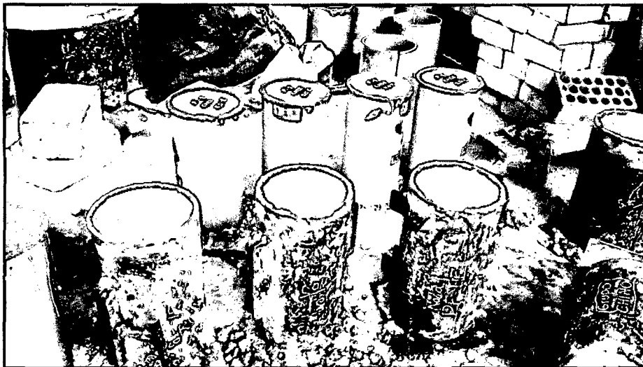
Fotografía N°10: Moldes ya enrasados.
