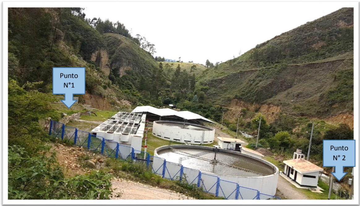
Figura 4 Puntos de muestreo de Punto N° 1 (afluente) y Punto N° 2 (efluente) de aguas residuales
