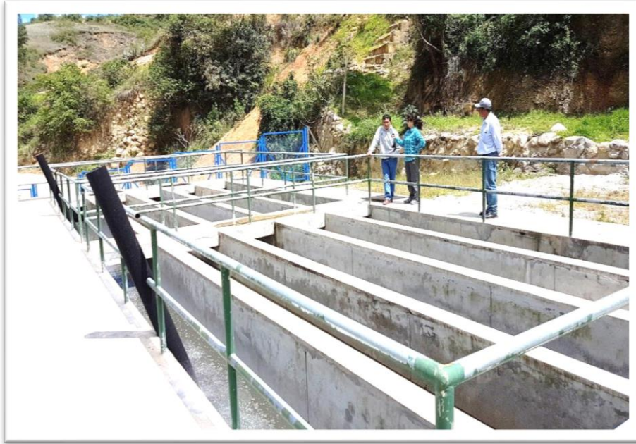
Fotografía N° 3. Tanque Imhoff
