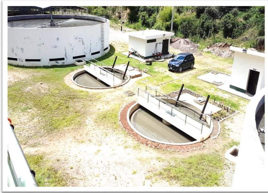
Fotografía N° 5. Sedimentadores
