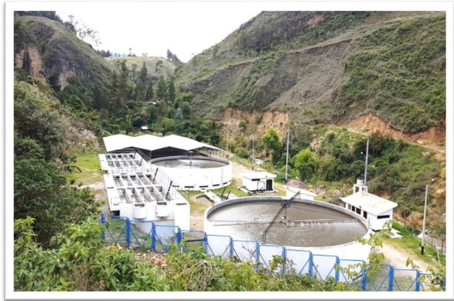
Fotografía N° 1. Vista de la Planta de tratamiento de aguas residuales de Cajabamba
