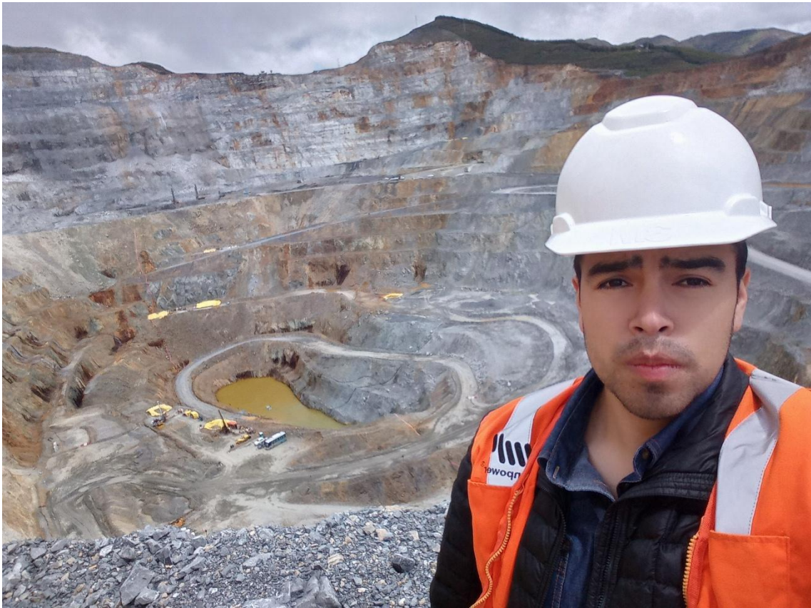
Vista de la poza colectora centro desde el área destinada a las visitas.
