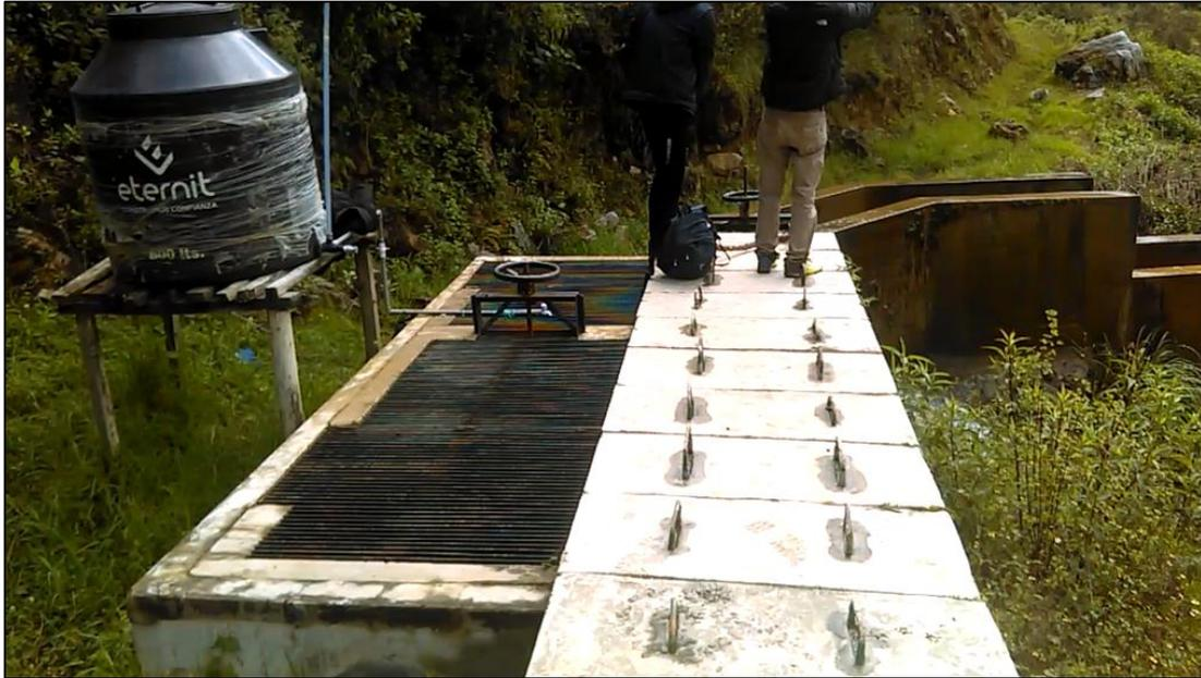
**Figura 15: Captación La Quesera: compuerta de regulación y dispositivo para mezcla rápida**
