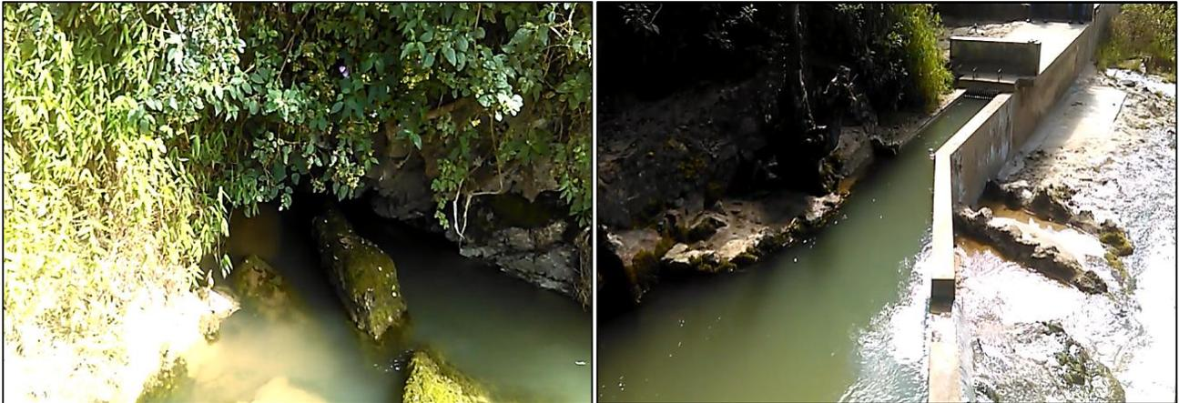
**Figura 13: Captación La Quesera: manantial, canal de derivación y cribado**
