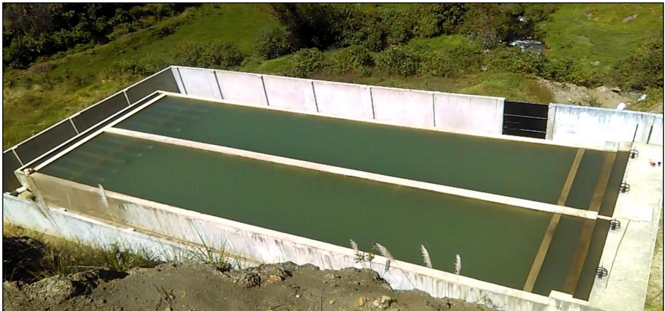
**Figura 16: Sedimentador de flujo horizontal – Pre-tratamiento**
