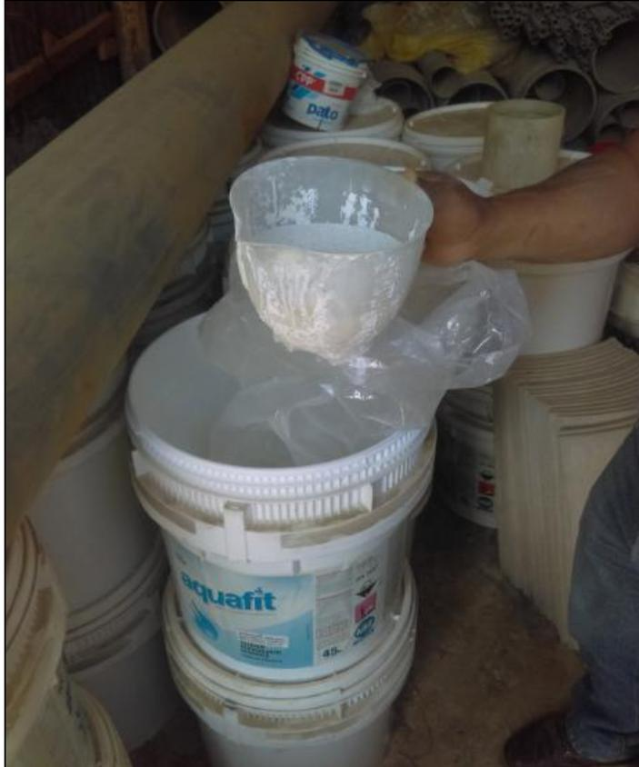
**Figura 28: Sistema de cloración en reservorio**
