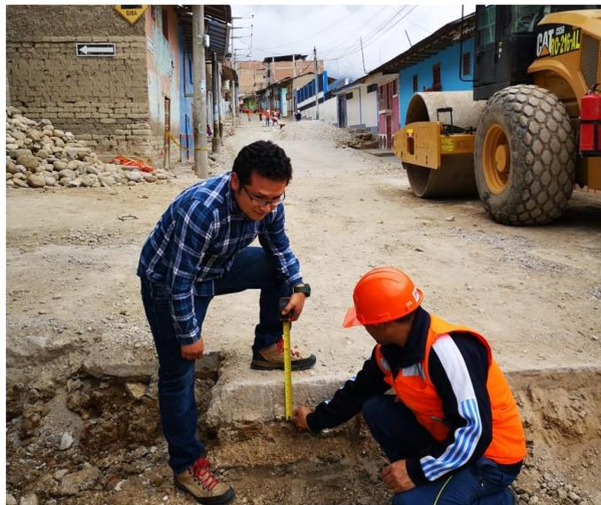
**Fotografía 10.** Espesor de la base y la losa del pavimento existente.
