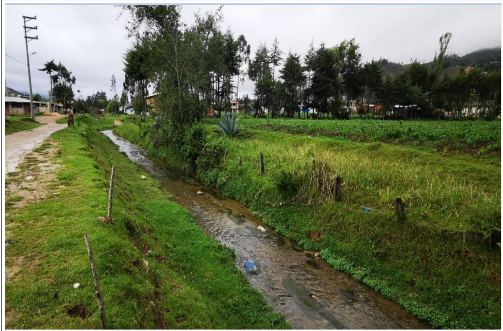
Imagen N° 11: áreas productivas y viviendas en el barrio Chacapampa, expuestas al peligro muy alto de inundación (12/12/2019).
