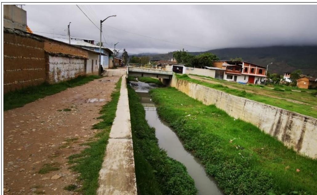
Imagen N° 1. Muestra los elementos expuestos en la zona de muy alto peligro de inundación en la intersección del jirón Sucre y jirón Pedro Ortiz Montoya, se evidencia que las paredes de las viviendas son de tapial y están cercanas al Río Chico. (02/12/2019)
