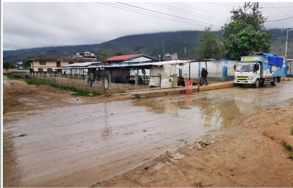
Imagen N°3: evidencia la infraestructura de salud (Essalud y Red III de Salud) emplazada en la zona de peligro muy alto de inundación (03/12/2019).
