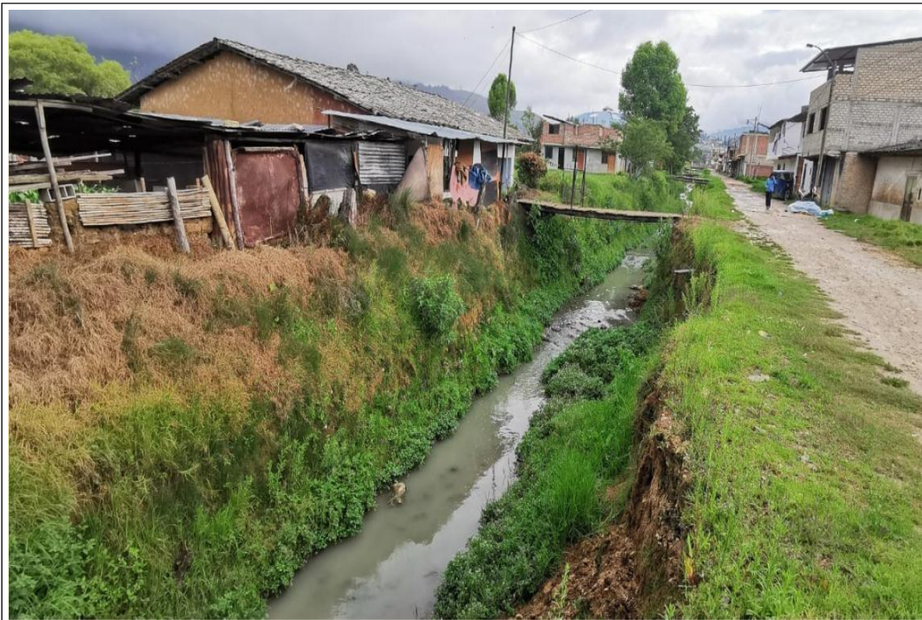
Imagen N° 6: se evidencia construcciones al borde del cauce del Río Chico, no se respetando las fajas marginales y exponiéndose al peligro muy alto de inundación (03/12/2019).
