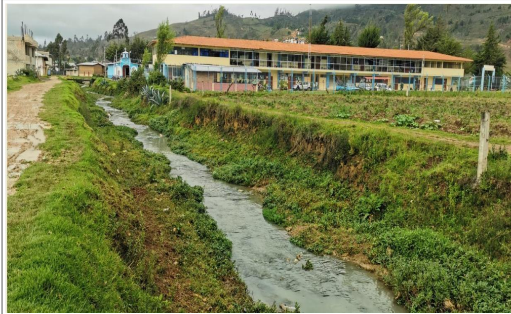
Imagen N° 9: Escuela Académico Profesional de Ingeniería Ambiental de la Universidad Nacional de Cajamarca, ubicada en zona de peligro muy alto de inundación, no se realiza la limpieza del cauce del Río Chico y no cuenta con medidas de protección (08/10/2019)
