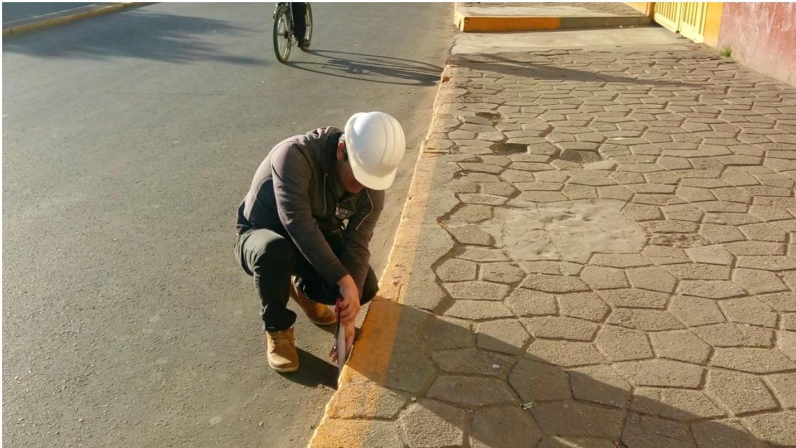
Imagen 03: Medición de cunetas y veredas, Av. Atahualpa cuadra 2 frente a la institución educativa la Florida.
