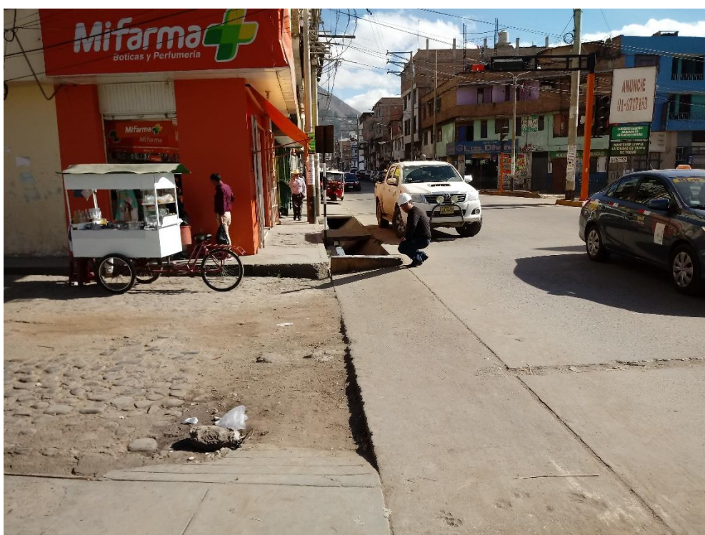
Imagen N° 08: Mediciones de cunetas y veredas Interseccion 02. Av. Vía de Evitamiento Norte – Av. Angamos.
