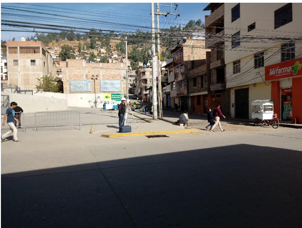
Imagen N° 06: Levantamiento topográfico Interseccion 02. Av. Vía de Evitamiento Norte – Av. Angamos
