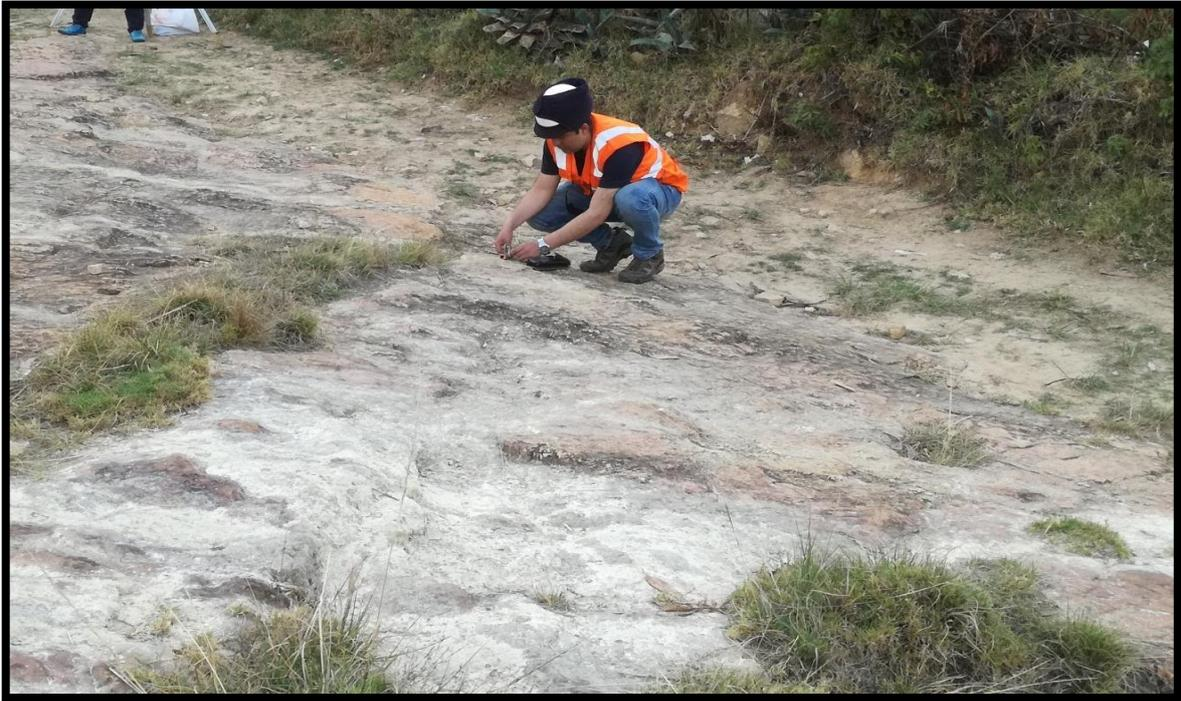
*Figura 6.5: Medición de peraltes con eclímetro*
