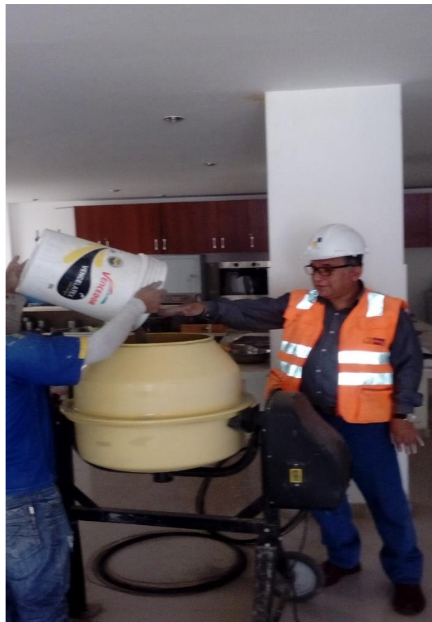
Foto N° 4: Vaciado de cemento y los agregados y agua a la máquina mezcladora de concreto f'c=350 \text{ Kg/cm}^2 .
