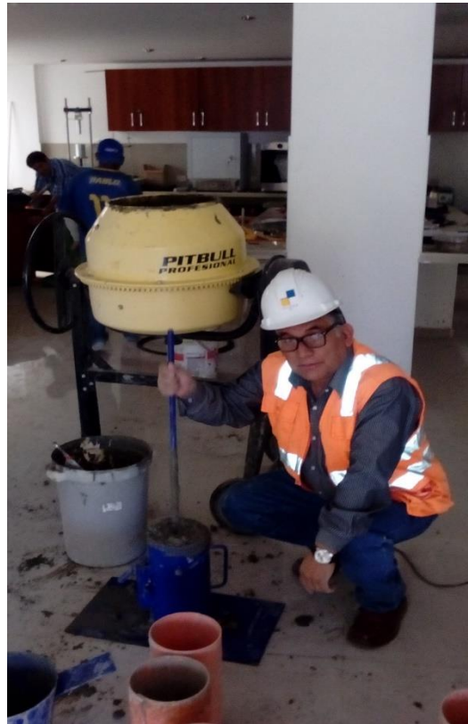
Foto N° 9: Trabajos de fabricación de las probetas de concreto con aditivo sika visocrete – 3330 a diferentes porcentajes.
