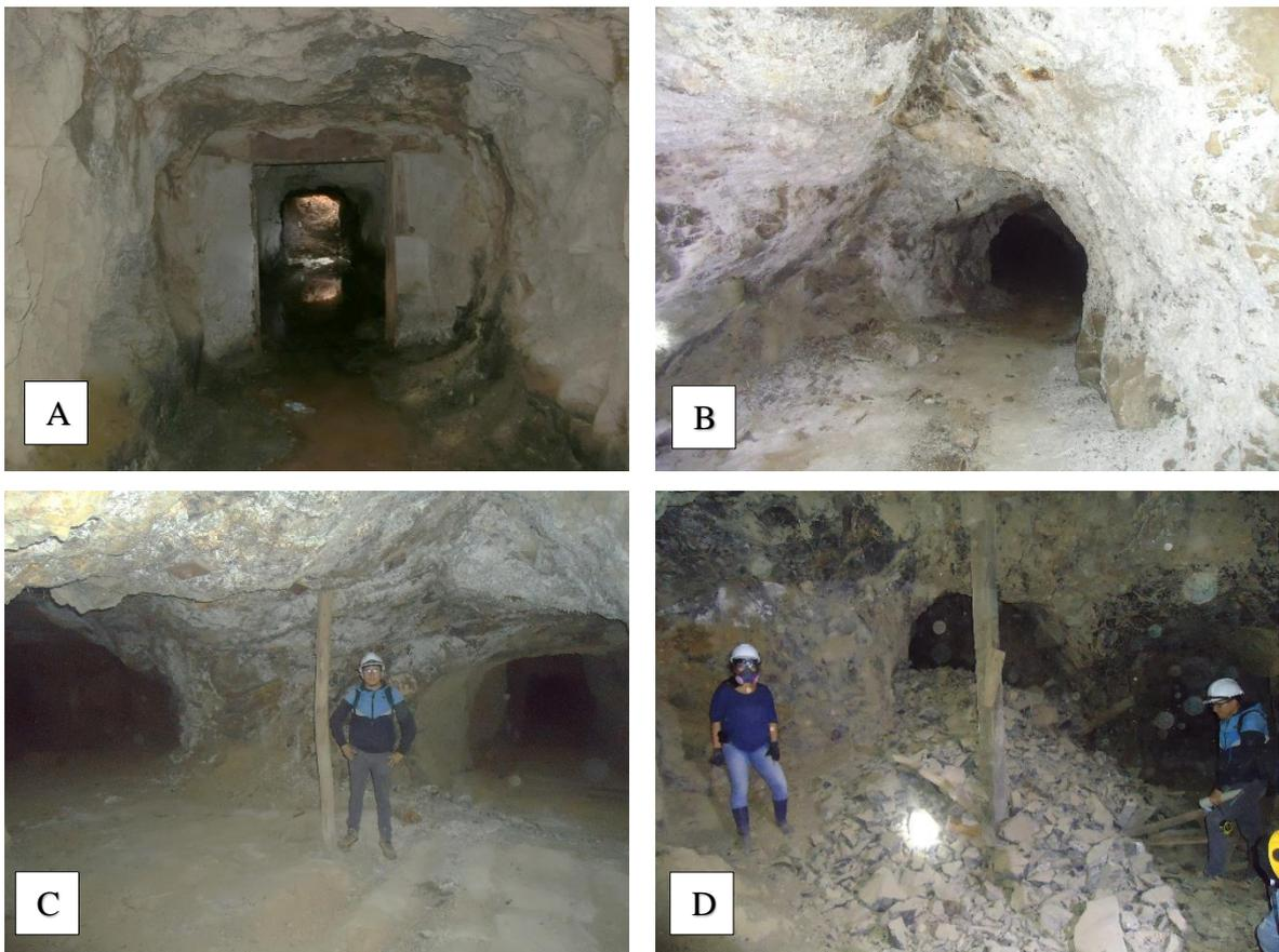
Figura 4.3. Zonas afectadas por humedad y flujos de agua.
