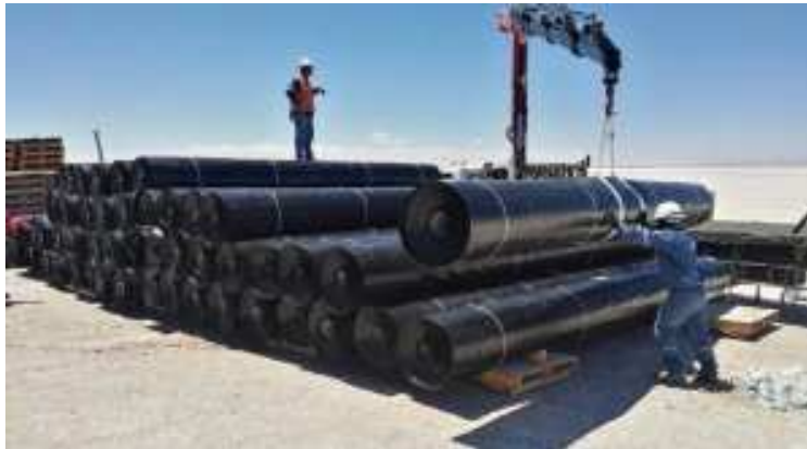
Figura 14. Rollos de geomalla apilados correctamente
