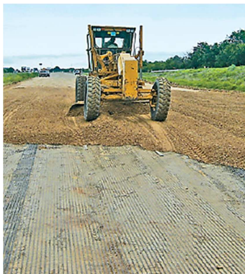
Figura 22. Tendido de material sobre la geomalla
