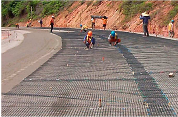
Figura 17. Colocación de la geomalla en curva
