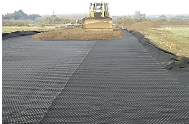
Figura 21. Geomalla alineada y tensada
