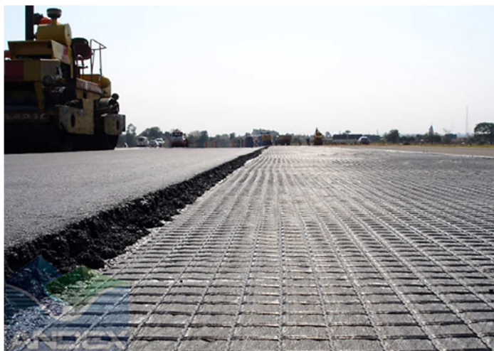
Figura 23. Procedimiento de compactación tradicional
