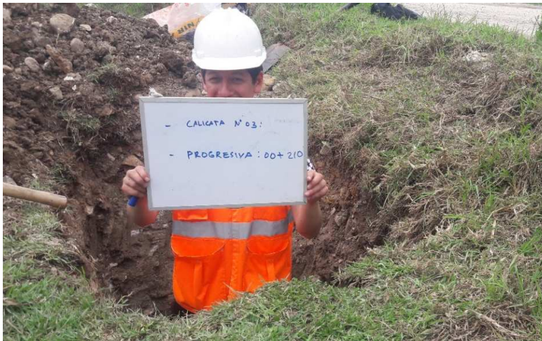
Figura 60. Realización de calicata N° 3
