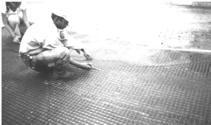
Figura 18. Corrección de arrugas y corte de la geomalla
