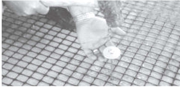
Figura 19. Fijación de la geomalla por medio de clavijas
