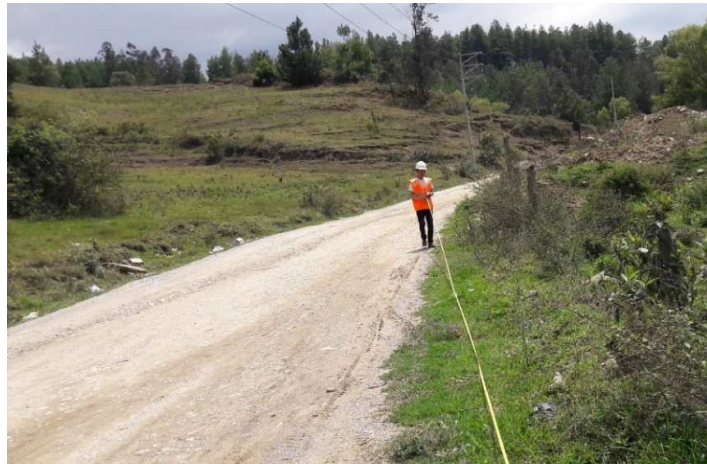
Figura 57. Medicación de tramos cada 70 m para ubicación de Calicatas
