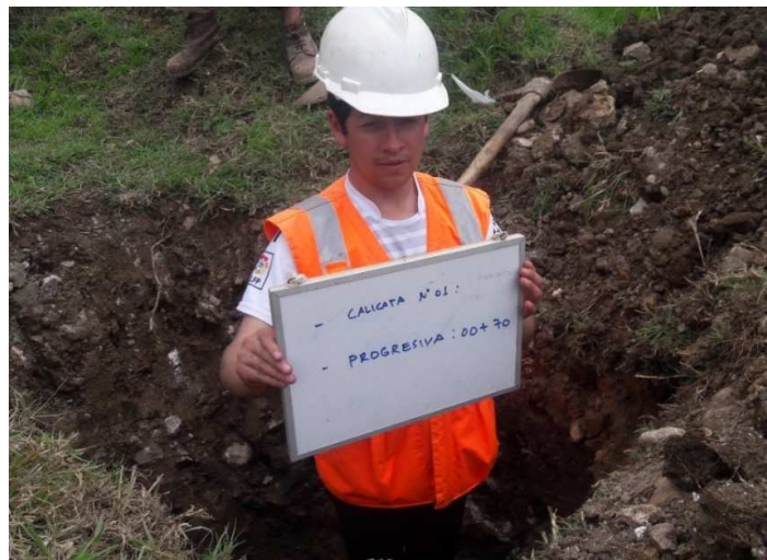
Figura 58. Realización de calicata N° 1
