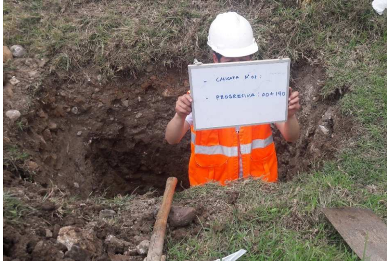
Figura 59. Realización de calicata N° 2
