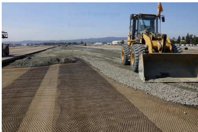
Figura 16. Traslape de la geomalla en campo
