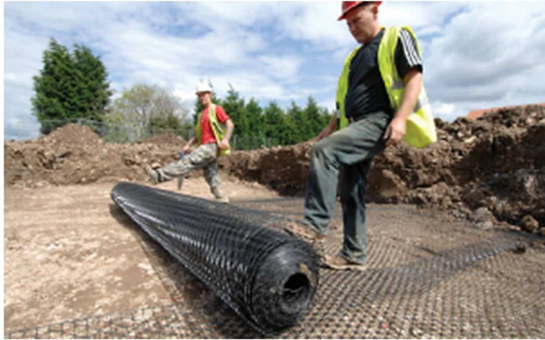
Figura 15. Colocación y tendido de la geomalla
