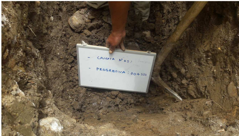
Figura 62. Realización de calicata N° 5
