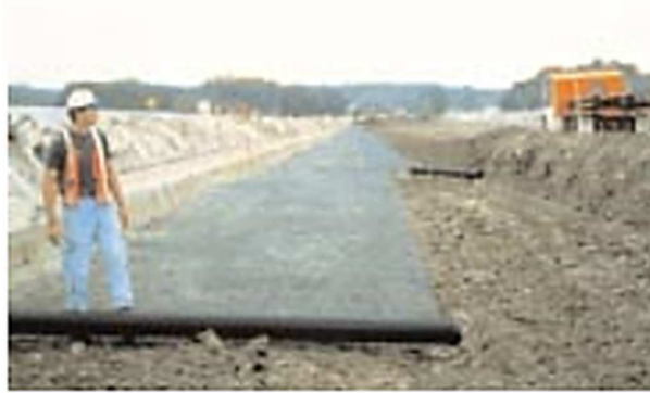
Figura 3. Tendido de la geomalla directo sobre una sub- rasante blanda
