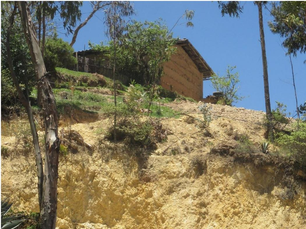
**Fotografía N° 10.-** La vivienda está asentada encima de un talud, el cual está compuesto de material granular muy meteorizado, este factor en conjunto con las altas precipitaciones pone en riesgo a todas a las viviendas que presentan el mismo problema.
