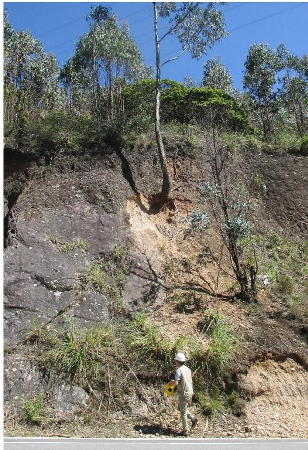
**Fotografía N° 04.-** El terreno está deslizando muy lentamente, prueba de ello es la torcedura del árbol en su parte inferior.
