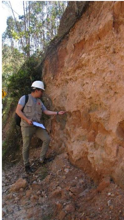
**Fotografía N° 02.- Talud muy erosionado compuesto de materiales finos**
