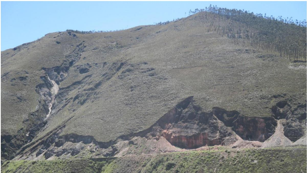
**Fotografía N° 08.-** Se muestra lo erosionados que están los taludes a lo largo de la vía y la escasez de vegetación.
