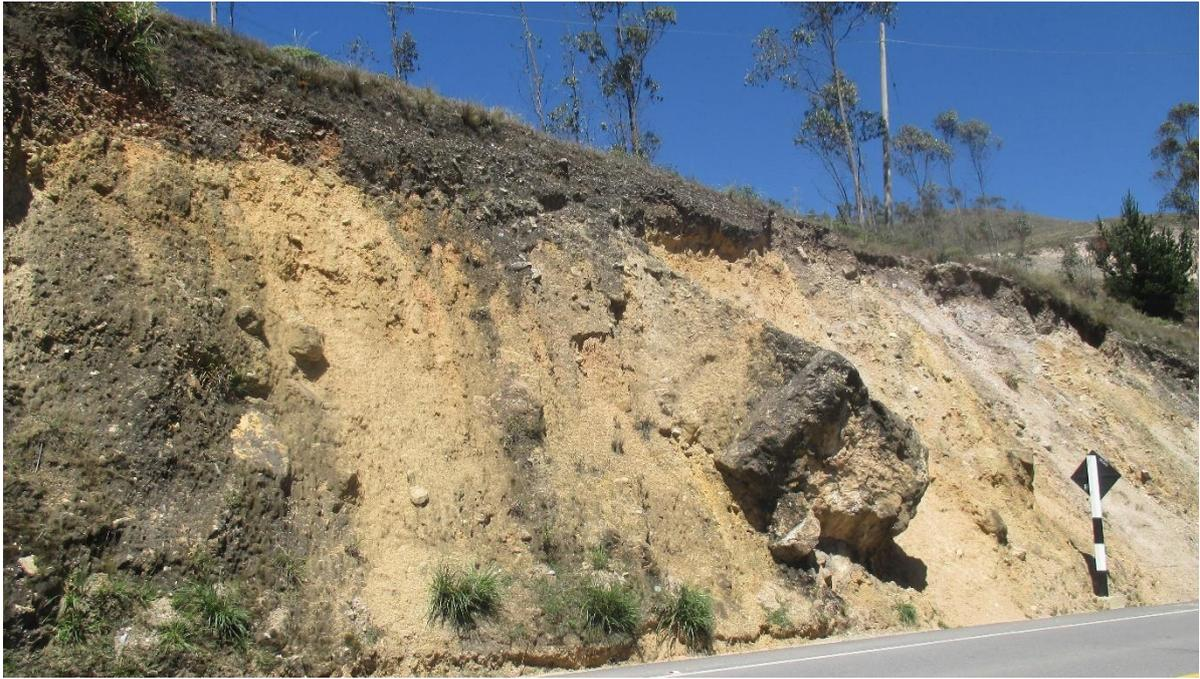
**Fotografía N° 07.-** Se muestra una roca de grandes dimensiones la cual en cualquier momento podría volcarse y generar accidentes, ya que el talud se encuentra muy erosionado.
