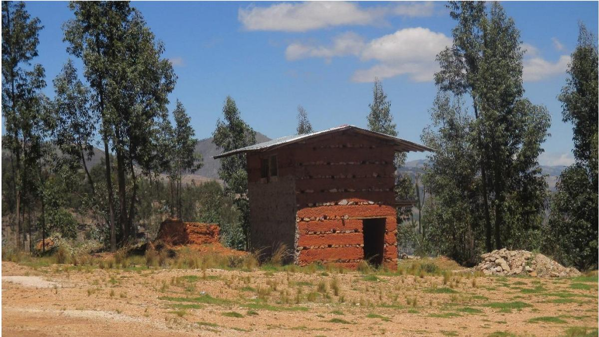
**Fotografía N° 09.-** La gran mayoría de construcciones de adobe presentes en el área de estudio no cuentan con un sobrecimiento; los muros se apoyan directamente en el suelo además de otros problemas tales como falta de refuerzo horizontal.
