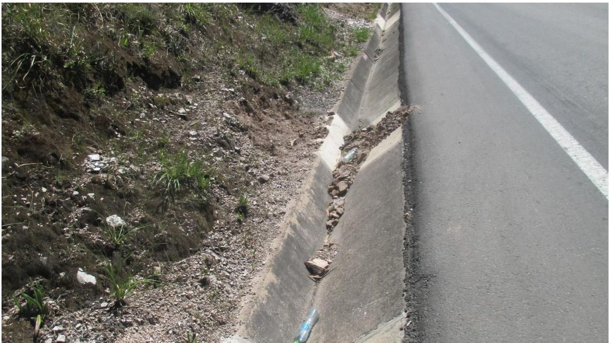
**Fotografía N° 06.-** Los materiales que caen desde los taludes ocupan las cunetas y continuamente se le debe hacer mantenimiento
