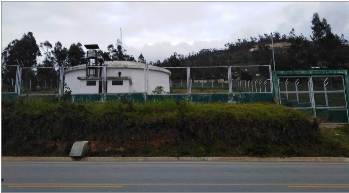
Figura N° 109: Vista del reservorio circular apoyado
