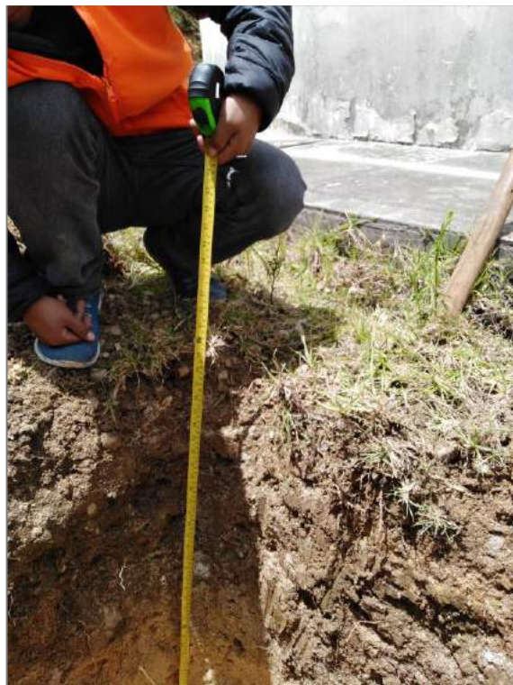
Figura N° 112: Medición de la altura de calicata
