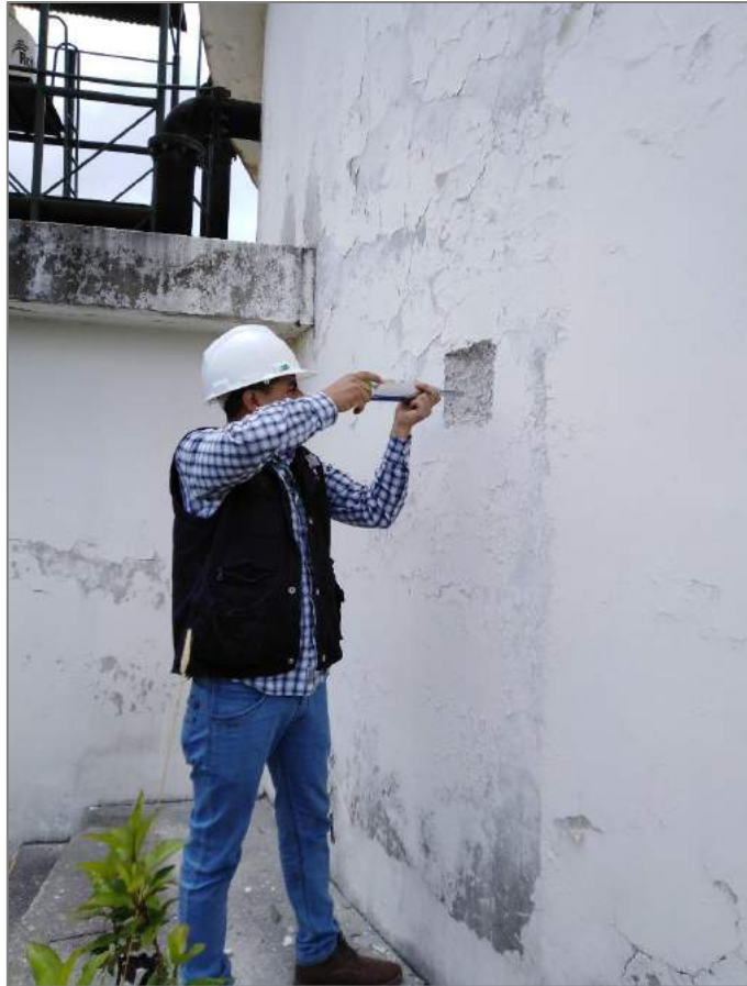
Figura N° 113: Ensayo de esclerometría en el muro circular
