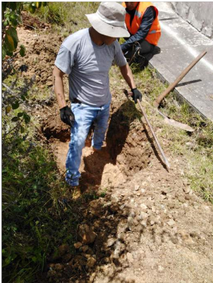
Figura N° 110: Excavación de calicata
