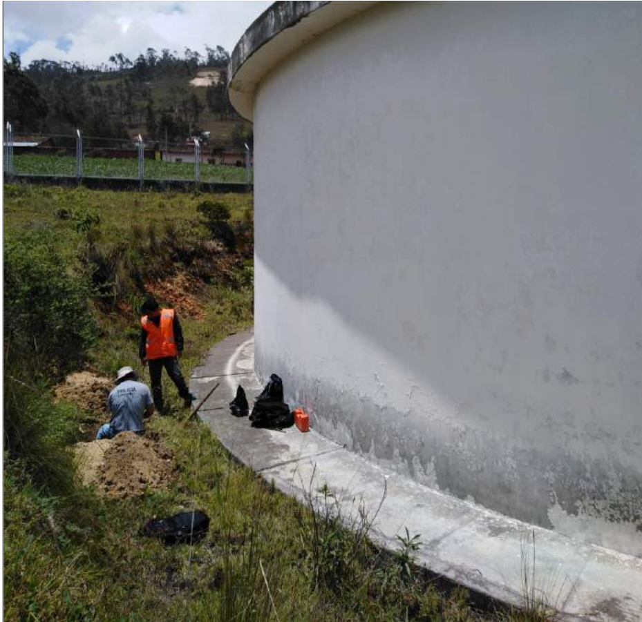
Figura N° 111: Excavación de calicata
