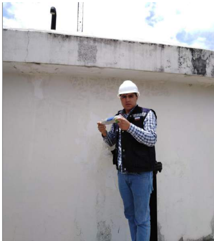
Figura N° 114: Registro del índice de rebote en la viga anular
