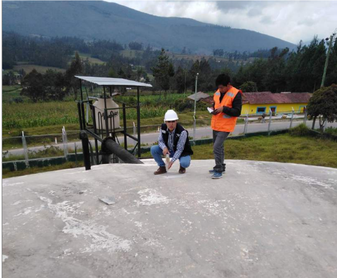
Figura N° 115: Ensayo de esclerometría en la cúpula
