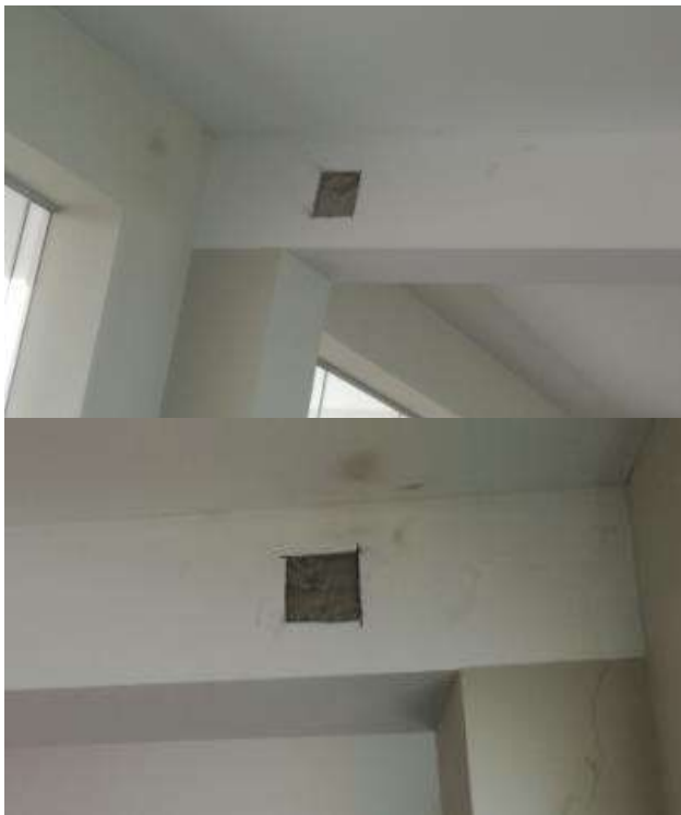
Fotografía 15 y 16: Ensayo de esclerometría en vigas y columnas en el módulo 02, tercer nivel
