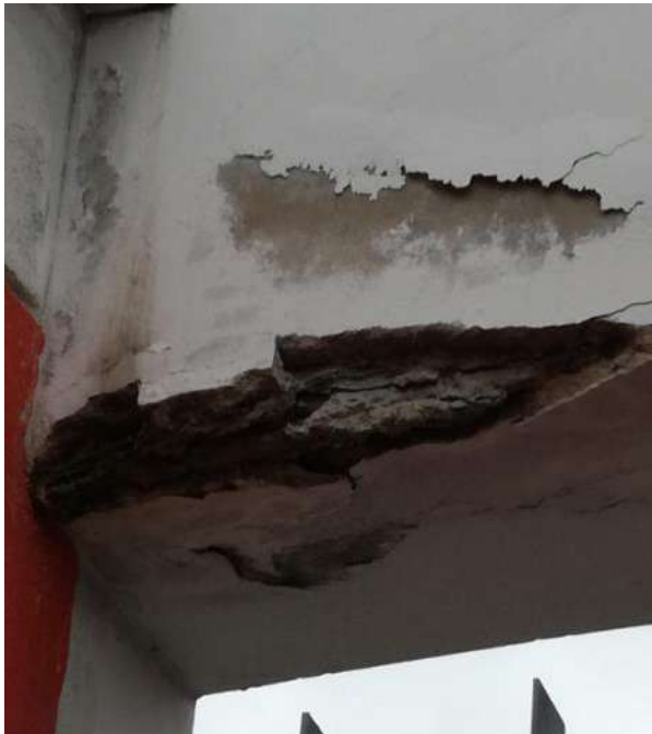
Fotografía 09 y 10: Grietas en columnas y muros en el cerco perimétrico.
