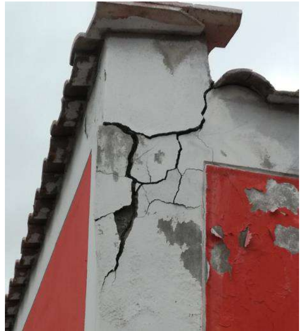
Fotografía 09 y 10: Grietas en columnas y muros en el cerco perimétrico.
