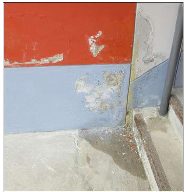
Figura 18: (a)(b) Filtraciones y Humedad en paredes
