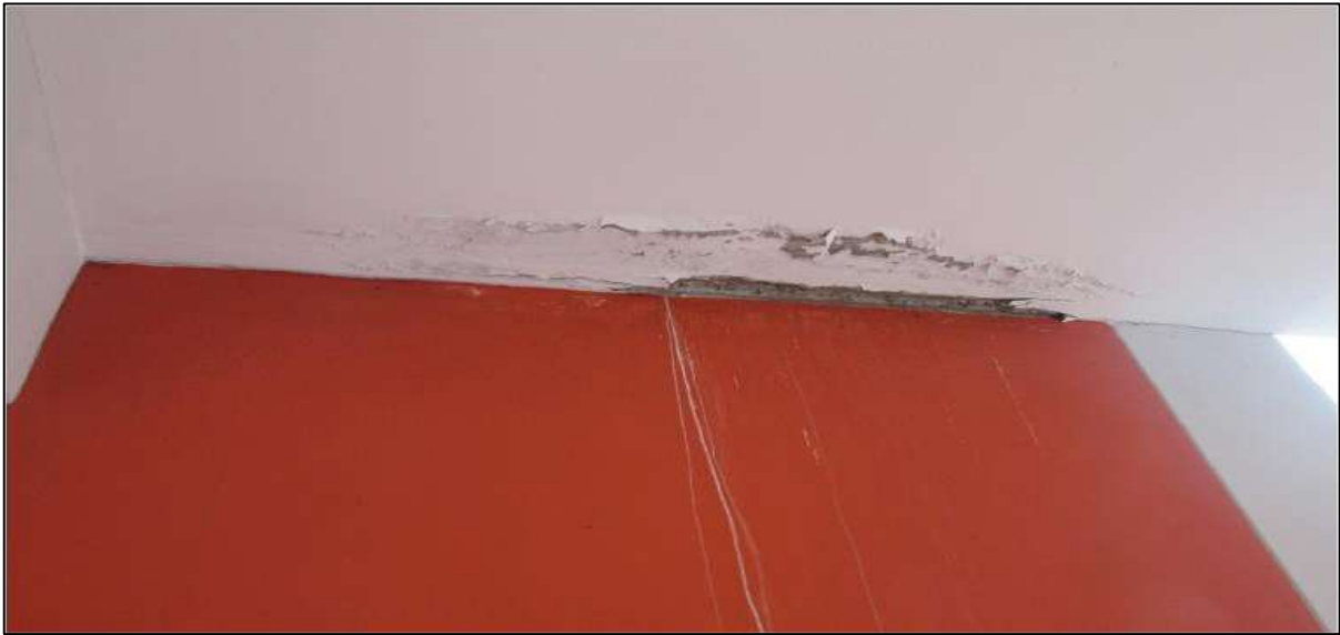
Figura 19: No existe junta de construcción entre el módulo M1 y escalera.
