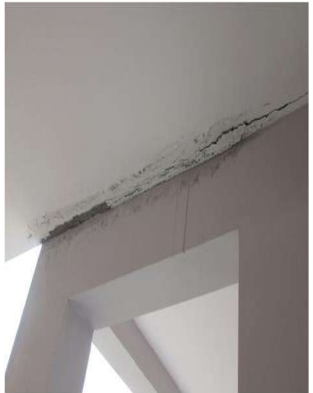
Fotografía 05 y 06: No existe junta de construcción entre módulos y escaleras
