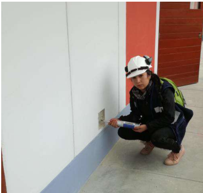
Fotografía 13: Ensayo de esclerometría en columna del módulo 01, segundo nivel.
