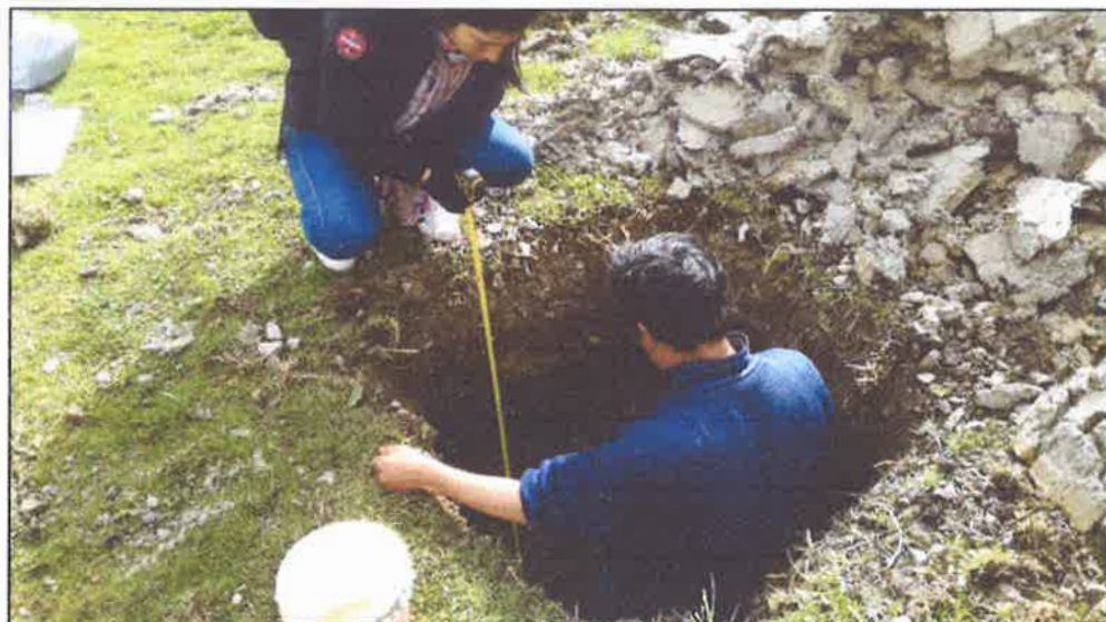
FOTOGRAFIA N° 02: SE OBSERVA LA CALICATA N° 01, DONDE SE ESTA REALIZANDO LA MEDICION.
