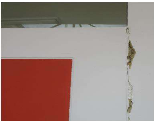
Fotografía 04 y 05: Fisura en unión pórtico-vano.
