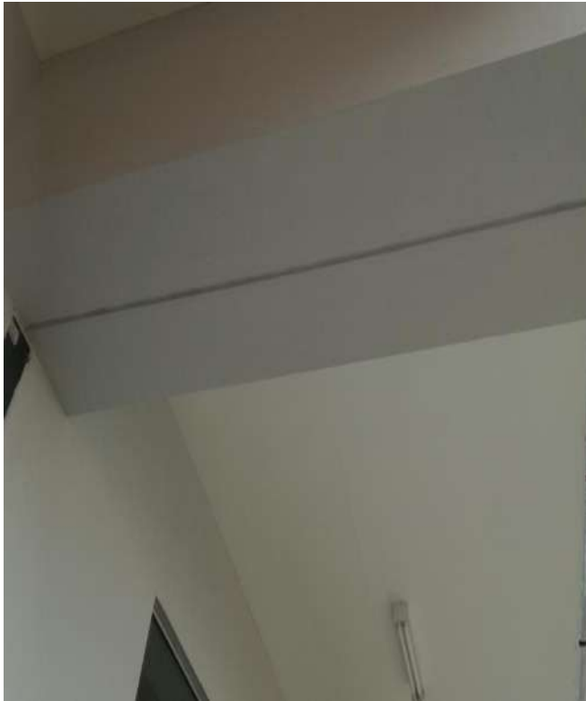
Fotografía 05 y 06: No existe junta de construcción entre módulos y escaleras
