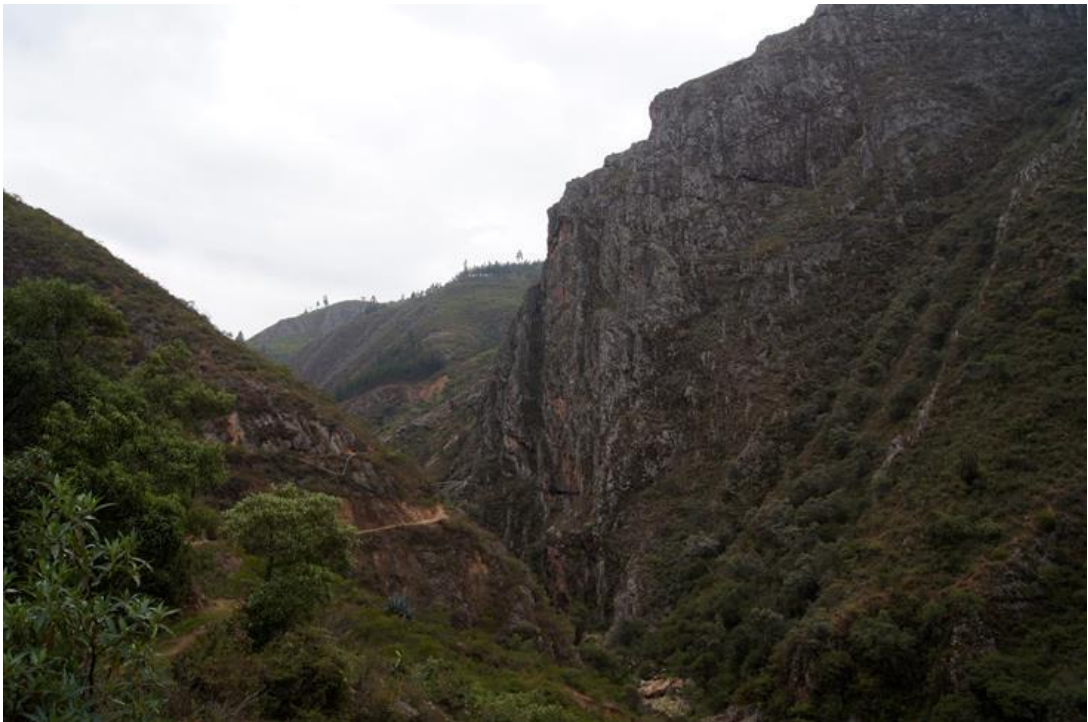
Figura 43. Ubicación de la boquilla de la Presa Huaynamango (aguas arriba).
