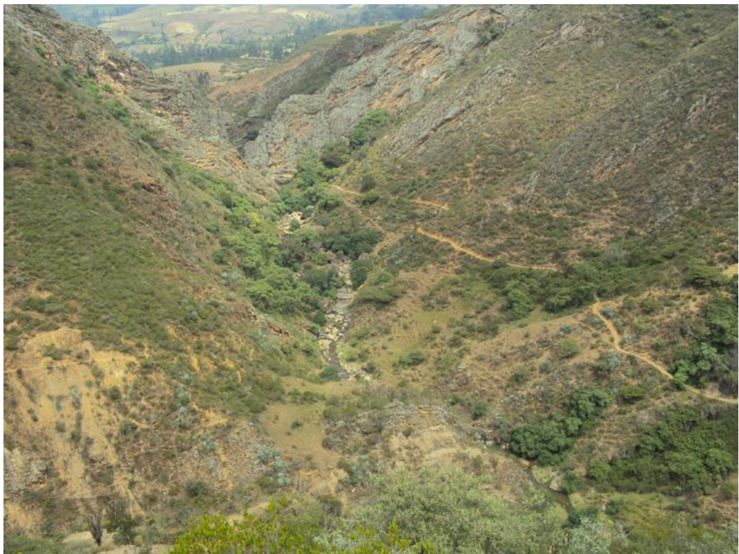
Figura 45. Vista de una parte del vaso de almacenamiento.
