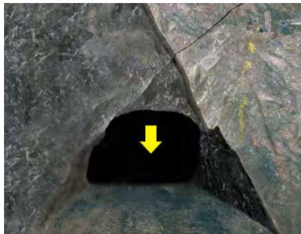
Figura 8. Cuña biplanar por las intersecciones de diaclasas en rocas fracturadas. Fuente: SNMPE, 2004.
