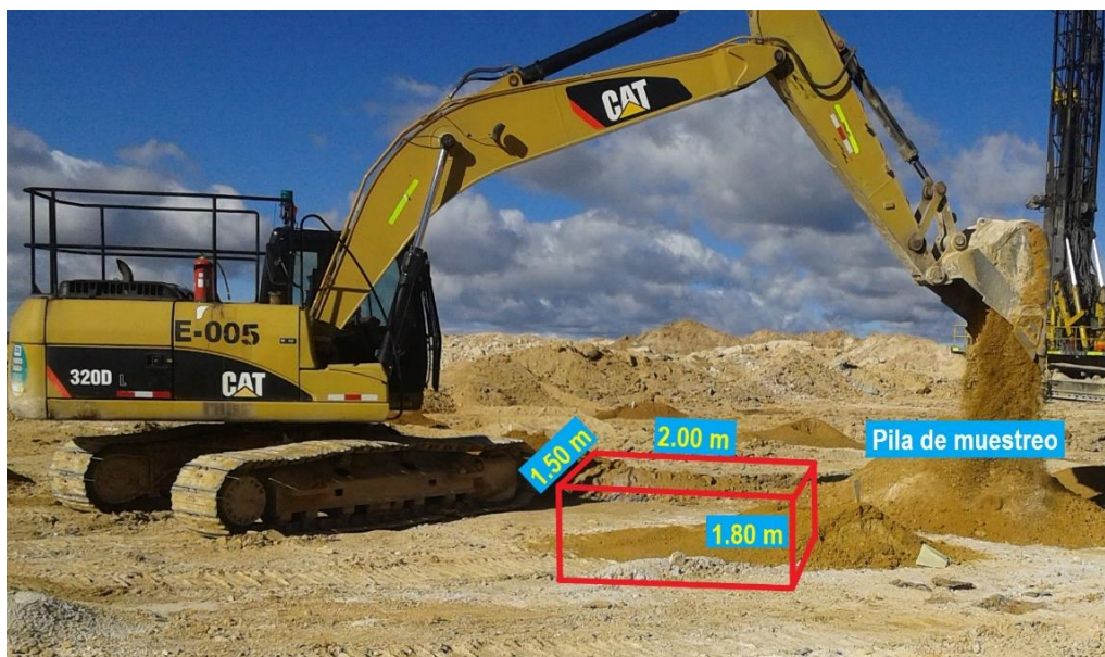
Foto 05. Excavación de la Calicata N° 2 con dimensiones de 2.0 x 1.5 x 1.8 m 3 teniendo un volumen de 5.4 m 3 en el banco de minado de una altura de 10 m, el material extraído es puesto a un costado, la cual sirvió como pila de muestreo para el análisis granulométrico y recojo en las bolsas de muestreo proveído por el Área de Geotecnia - Tajo Quecher Main.
