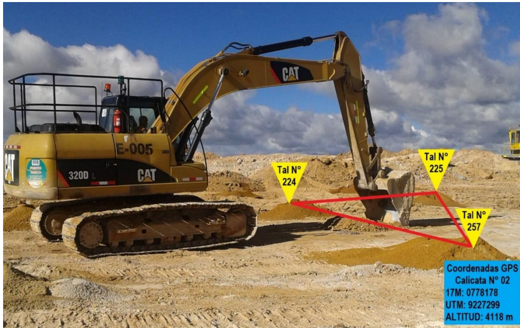
Foto 04. Punto de excavación y posicionamiento de la excavadora hidráulica para la Calicata N° 02 ubicada entre los Taladros N° 224, 225 y 257, georeferenciada mediante Coordenadas GPS en el Tajo Quecher Main.
