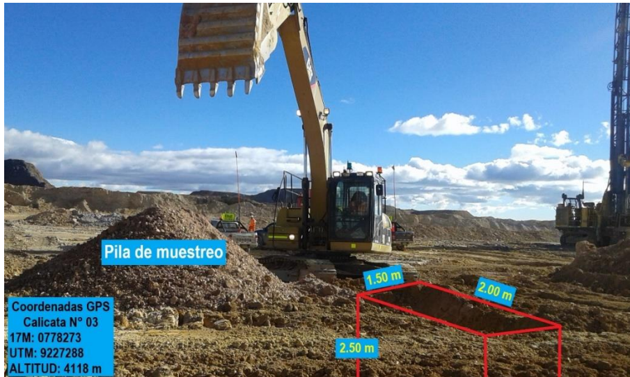
Foto 07. Excavación de la Calicata N° 3 con georeferenciación de coordenadas GPS y dimensiones de 2.0 x 1.5 x 2.5 m 3 teniendo un volumen de 7.5 m 3 en el banco de minado de una altura de 10 m, el material extraído es puesto a un costado, la cual sirvió como pila de muestreo para el análisis granulométrico y recojo en las bolsas de muestreo proveído por el Área de Geotecnia - Tajo Quecher Main.
