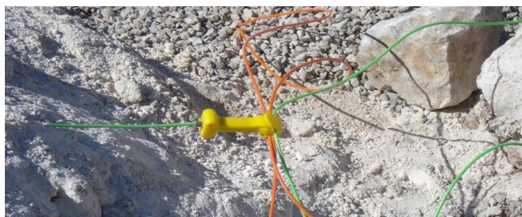
Figura 06. Amarre con conectores no eléctricos en superficie.
