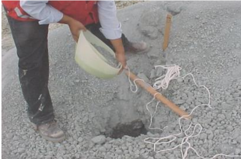
Figura 21. Instalación de taponex en un taladro de voladura.
