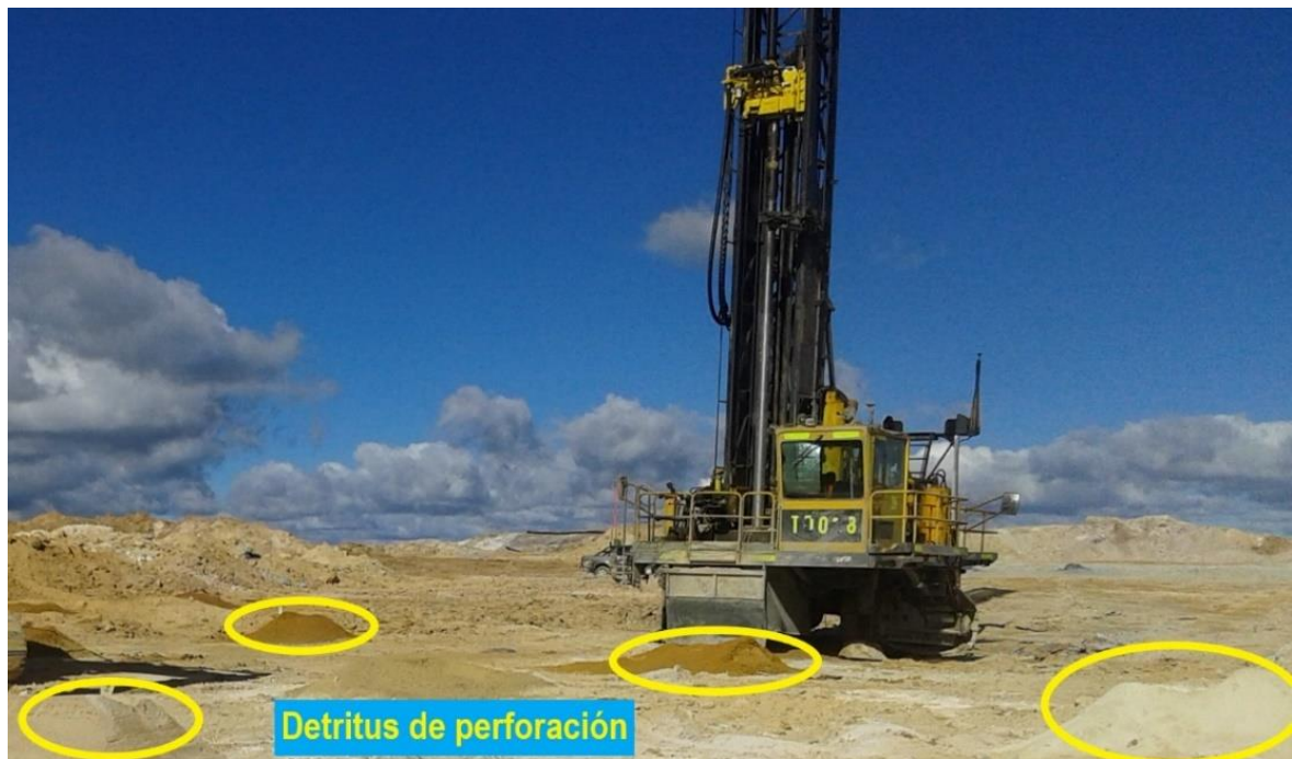
Foto 11. Zona de muestreo en el nivel 4080 mediante taladros de voladura (blastholes) – Tajo Quecher Main.
