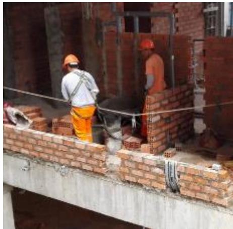
**Figura 23. Muros de albañilería simple**
