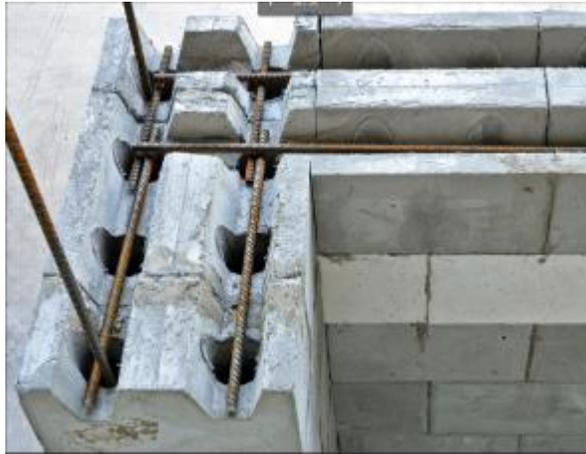
**Figura 24. Muros armados**
