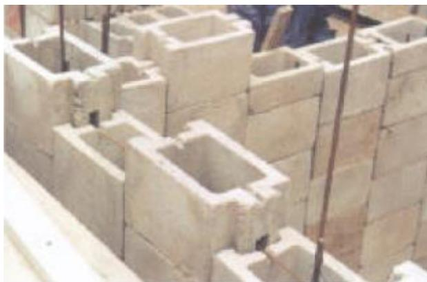
**Figura 11.** Construcción del módulo con bloques tipo grapa
