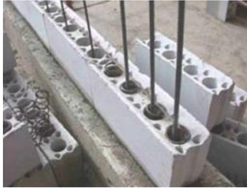
**Figura 12.** Construcción del muro con la placa P-14
