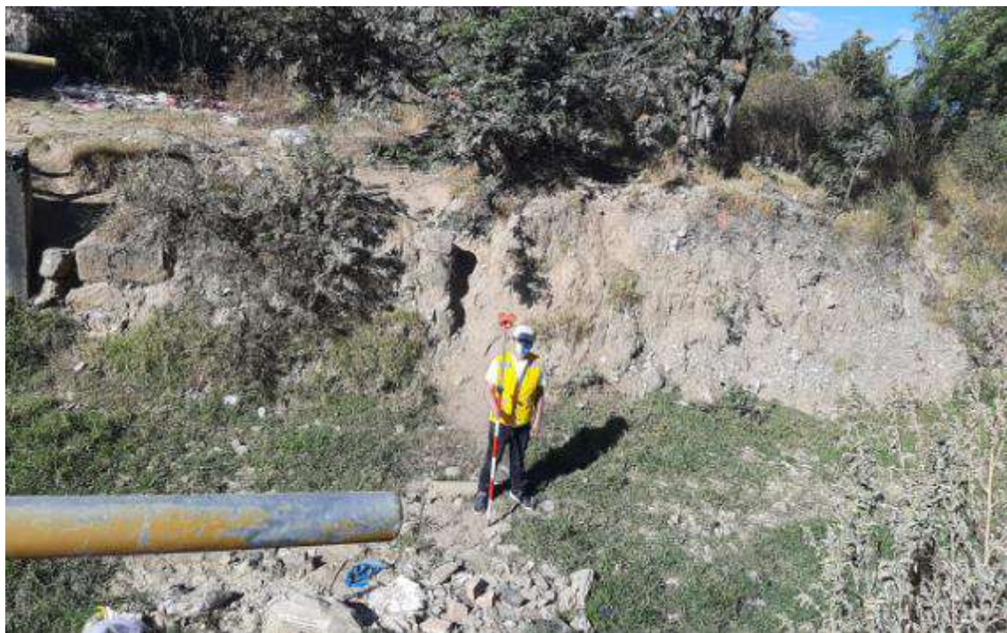
Fig. 40 Levantamiento topográfico del cauce de la quebrada, a la altura la prolongación de la Av. San Martín de Porres
