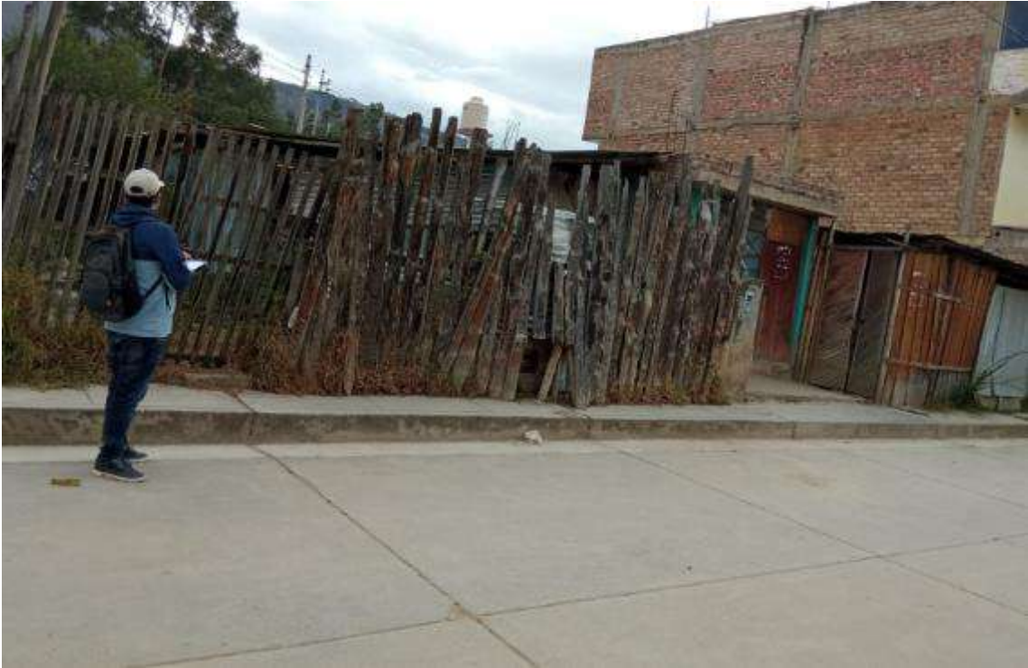
Fig. 36 Vivienda vulnerable ubicada en el Jr. 6 de julio
