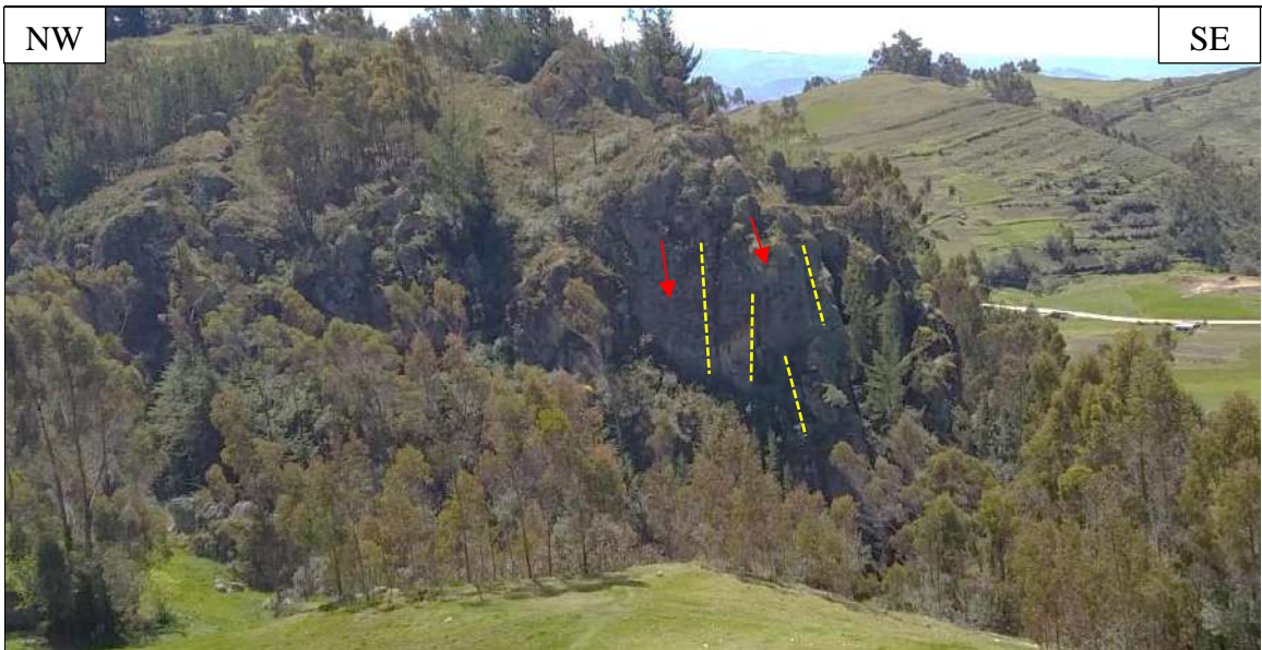
Foto 9: Desprendimiento de rocas por erosión subvertical.
