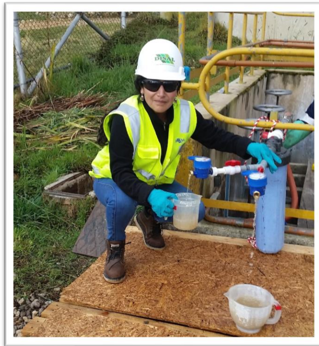
Figura 27. Verificación de funcionamiento de flujómetros.
