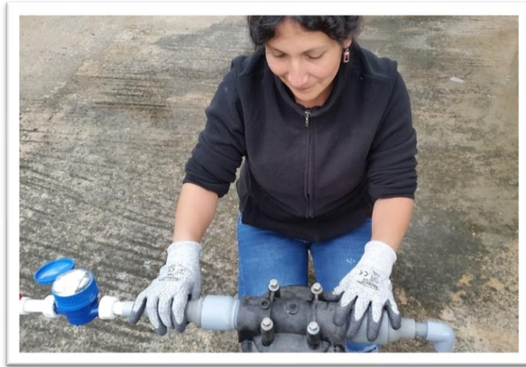
Figura 25. Armado de filtros con carbón activado.
