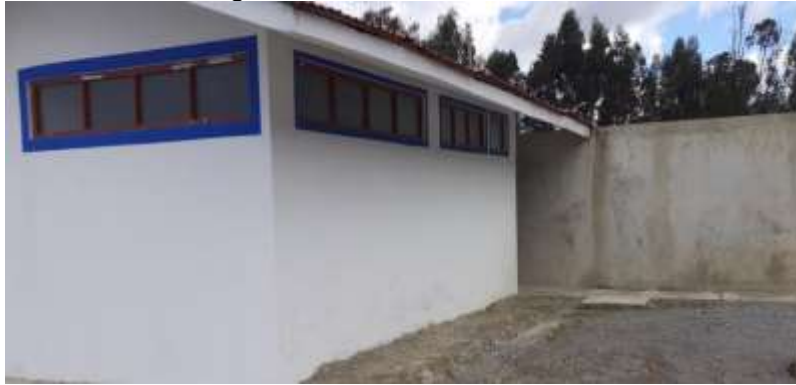
Figura 15: Caseta de cloración
