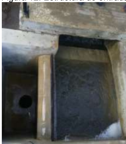
Figura 12: Estructura de entrada
