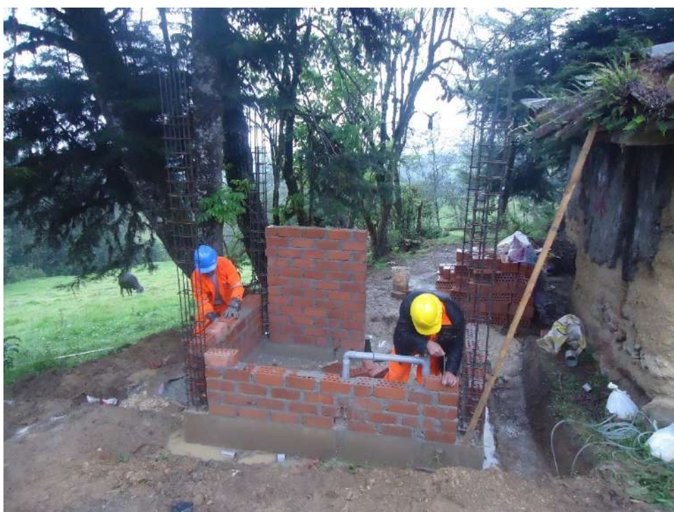
Figura N° 4: Asentado de ladrillo King Kong.
