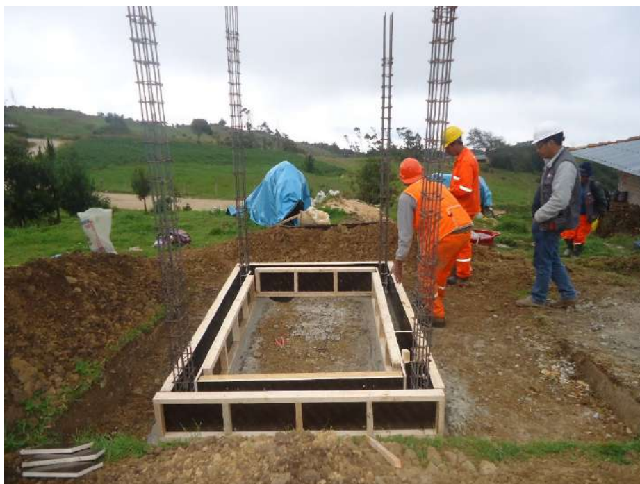
Figura N° 3: Encofrado de sobrecimientos
