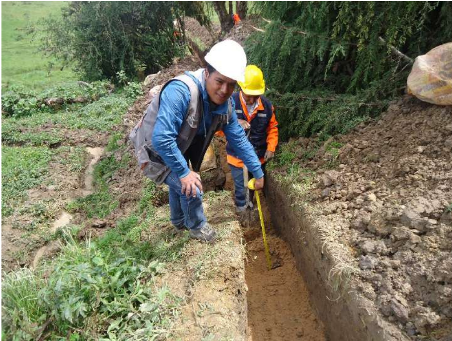
Figura N° 1: Verificación de medida en zanjas para redes de agua
