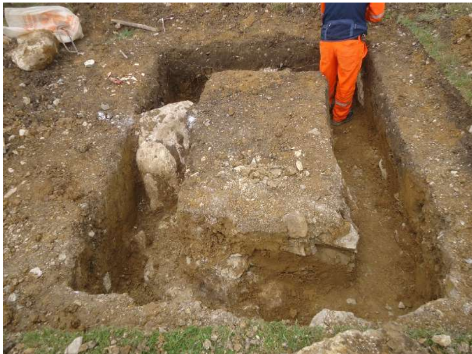
Figura N° 2: Excavación manual de zanja para cimientos corridos
