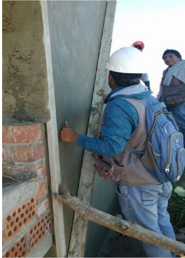
Figura N° 5: Verificación de tarrajeo.
