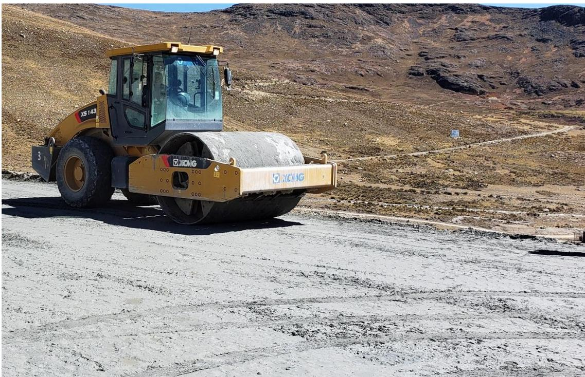
**Figura N° 17:** Rodillo XCMG XS143 compactando una capa de material de relave grueso en turno día
