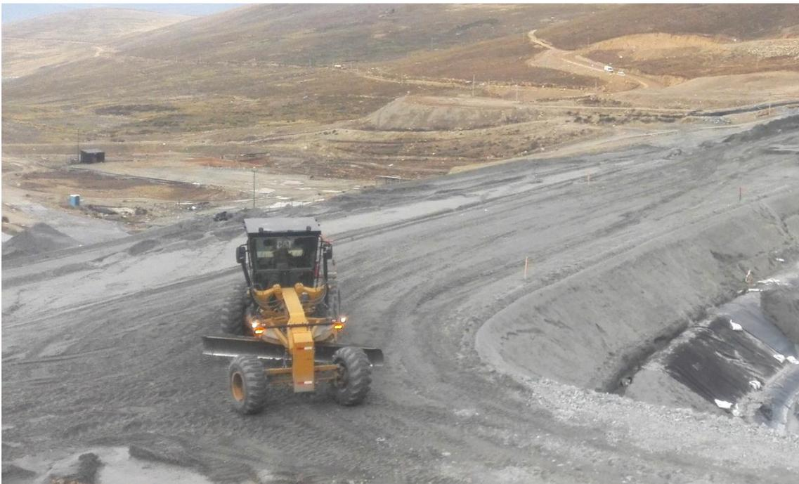
**Figura N° 19:** Motoniveladora 140K conformando una capa con material de relave grueso en turno día
