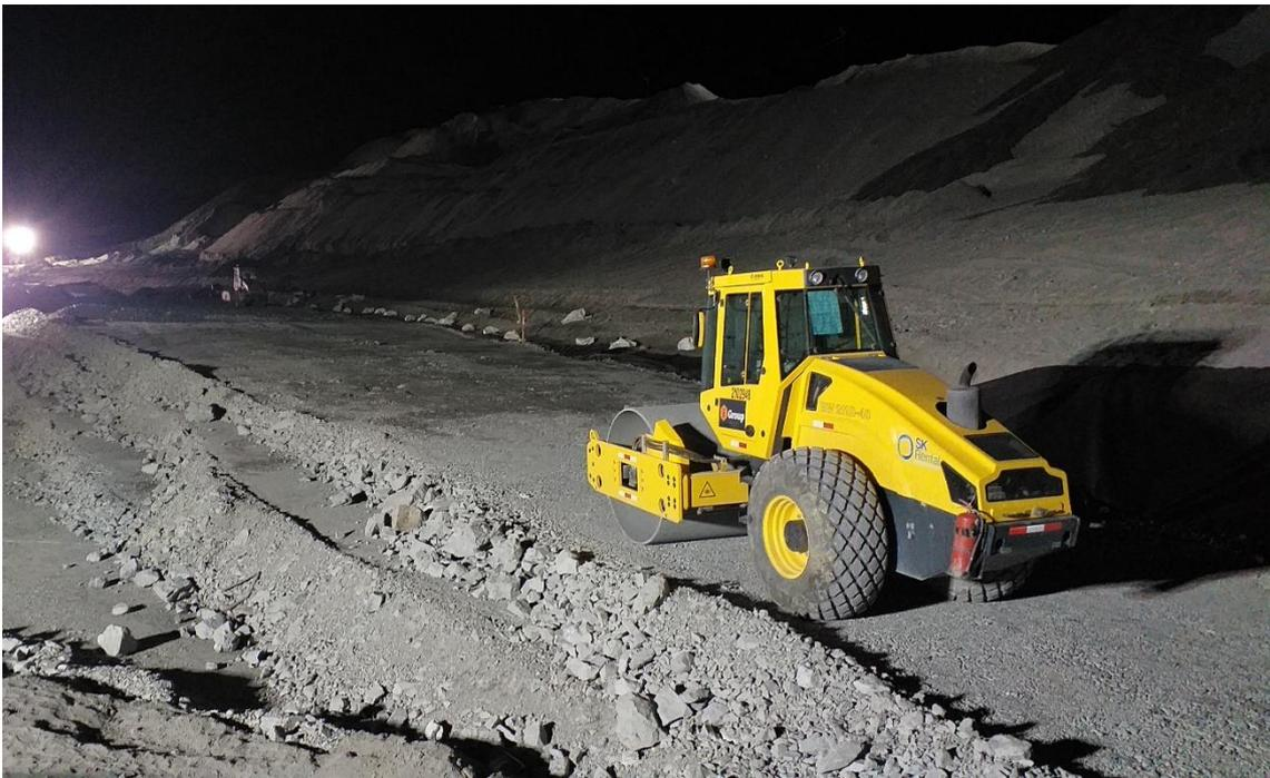
**Figura N° 15:** Rodillo Bomag BW 211 D-40 compactando una capa de material de desmonte de mina en turno noche
