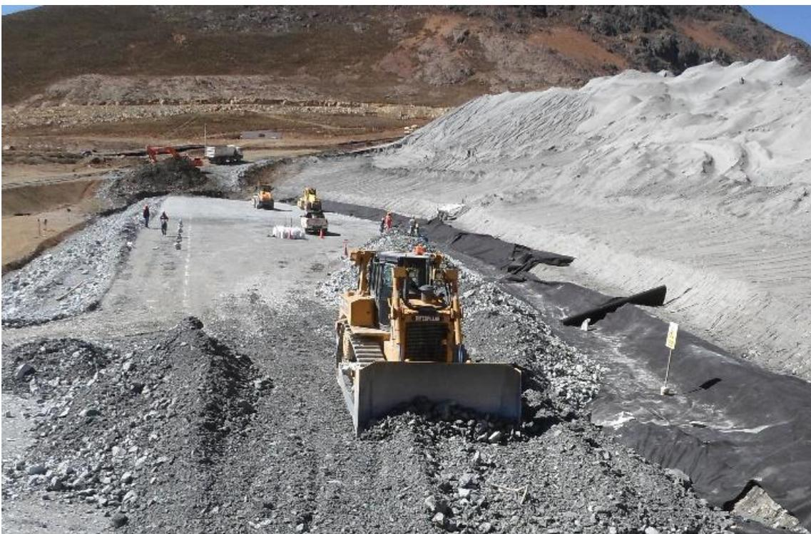
**Figura N° 13:** Tractor de orugas Caterpillar D6T conformando una capa con material de desmonte de mina en turno día
