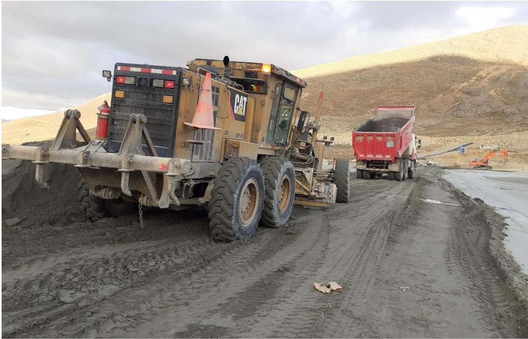
**Figura N° 18:** Motoniveladora 120K conformando una capa con material de relave grueso en turno día
