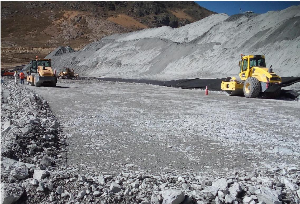
**Figura N° 16:** Rodillo Bomag BW 211 D-40 (lado derecho) inoperativo, mientras que el rodillo XCMG XS143 (lado izquierdo) lo releva en la actividad de compactación con desmorte de mina en turno día.
