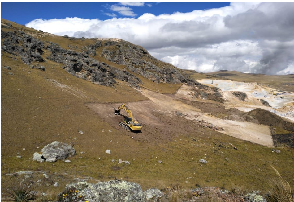
Foto 6. Limpieza y desbroce de material orgánico del frente 4 del PAD
