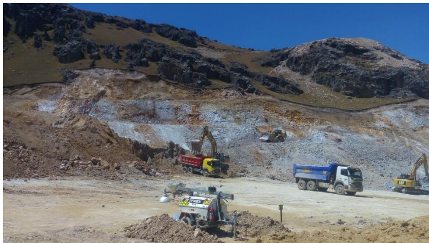
Foto 16. Control de pisos en carguío en el frente 3 del PAD
