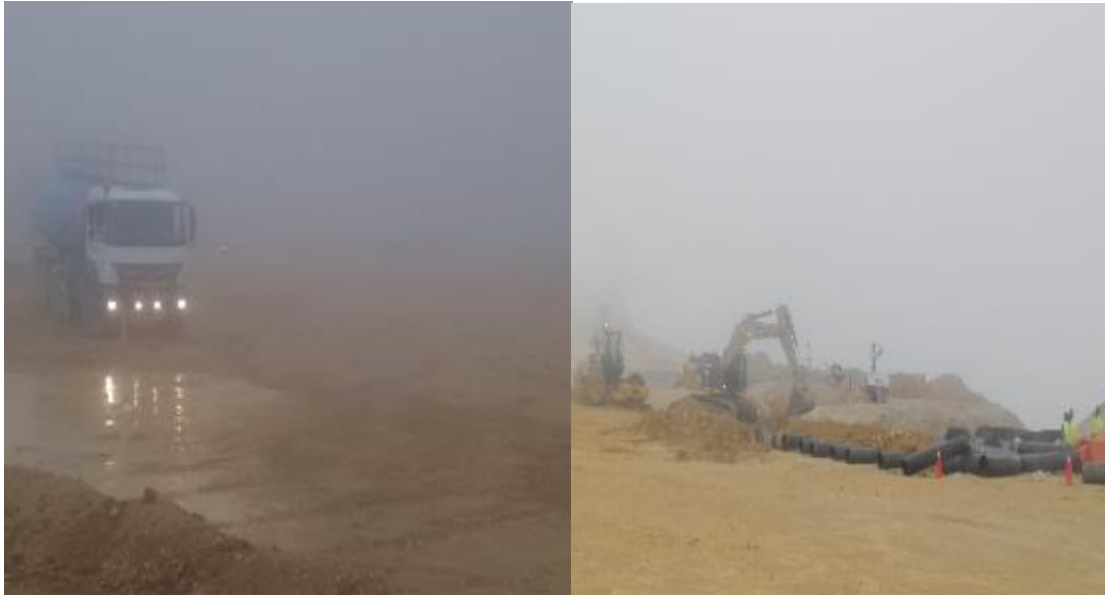
Foto 13. Empozamiento de agua en el PAD por condiciones climáticas
