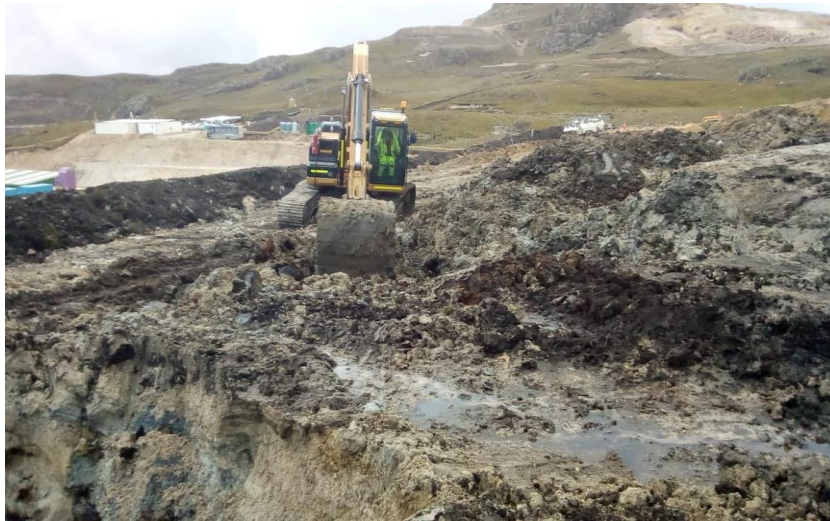
Foto 9. Carguío de material inadecuado en el frente 1 del PAD
