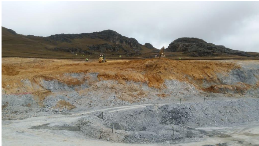
Foto 8. Corte de suelo de baja permeabilidad en el frente 3 y 4 del PAD
