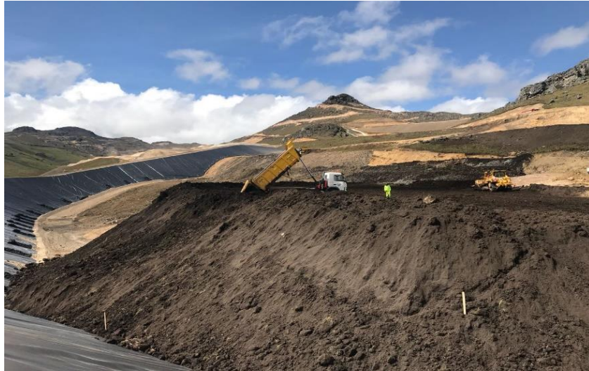
Foto 7. Descarga de topsoil en depósito DMO2
