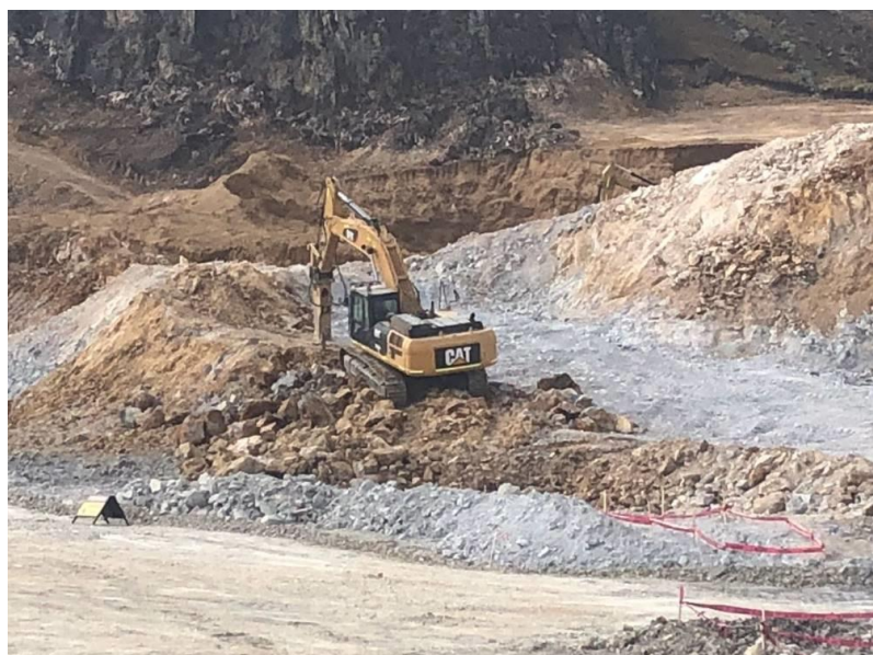
Foto 10. Excavadora martillo realizando corte en zona rocosa
