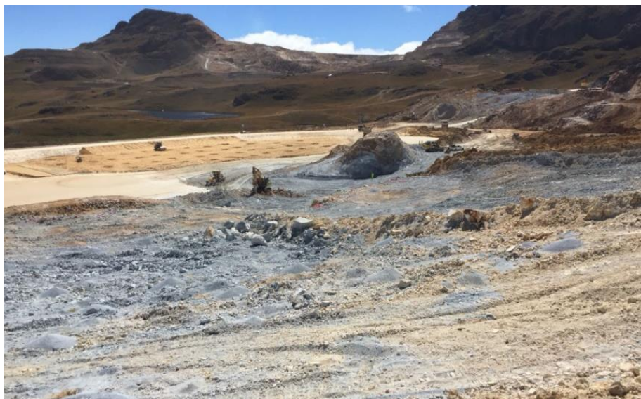
Foto 11. Corte simple de material para nivelación del PAD en el frente 3
