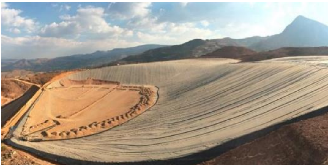
Figura 1. PAD de lixiviación construido (Cárdenas, 2017)
