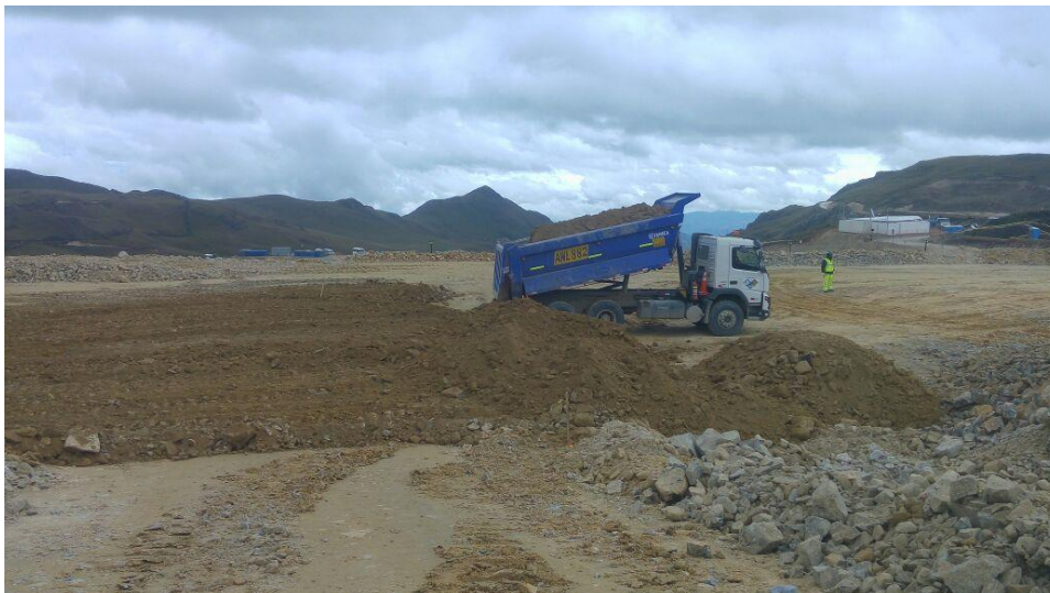
Foto 12. Transporte de material de relleno al frente 1
