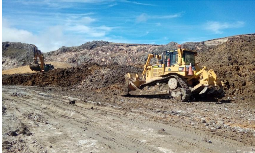
Foto 19. Empuje de material inadecuado en depósito DMI
