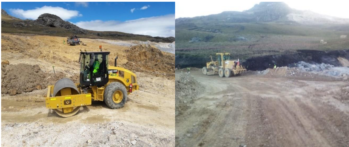
Foto 18. Motoniveladora y Rodillo realizando Mantenimiento de vías
