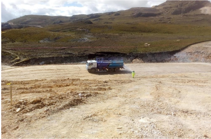
Foto 17. Riego de vías para disipación del polvo en el PAD, accesos y botaderos
