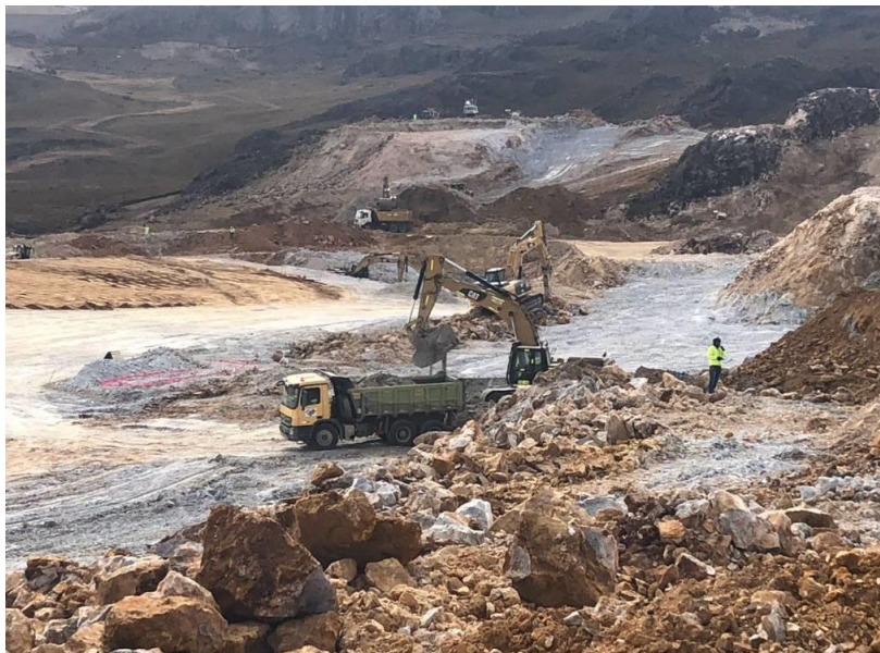
Foto 23. Carguío de roca producto de voladura
