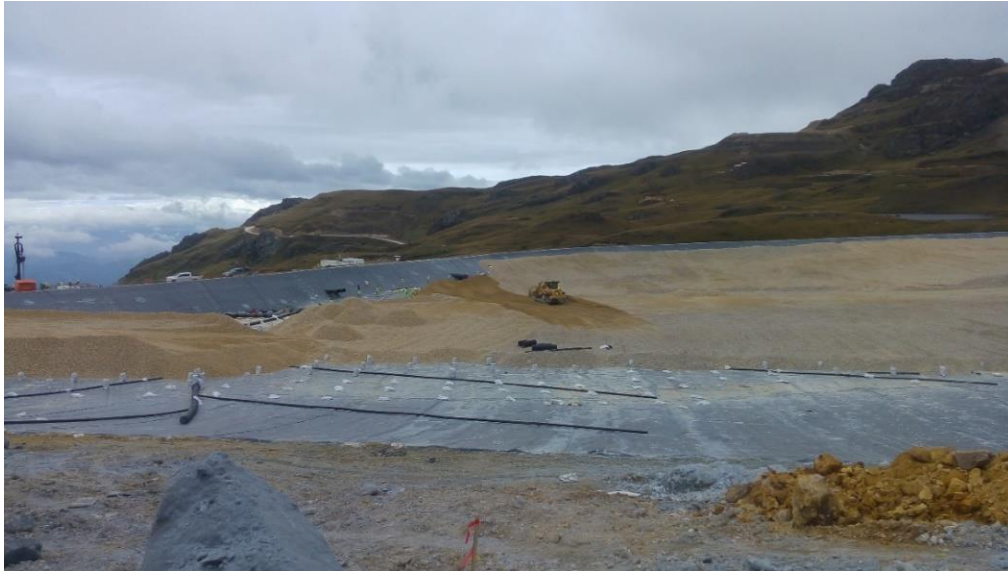
Foto 5. Instalación de Tuberías de Solución en el PAD CN
