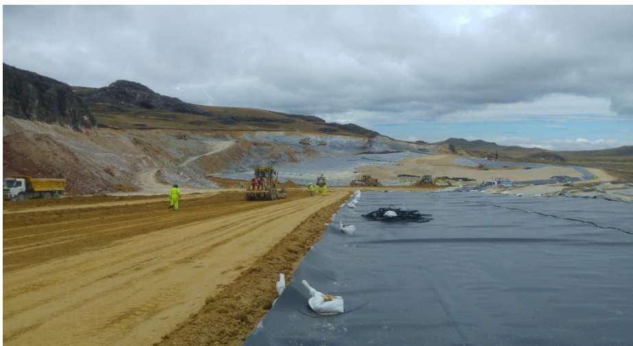
Foto 4. Colocación de suelo de baja permeabilidad en el PAD CN
