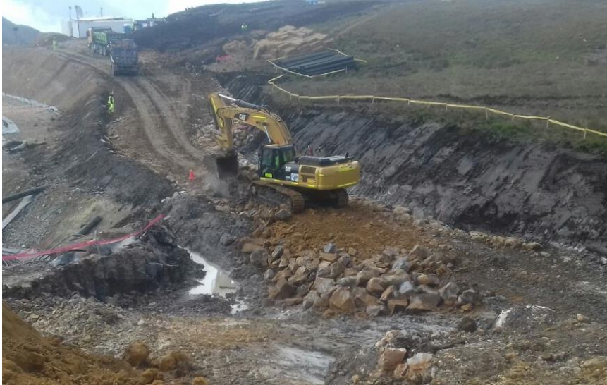
Foto 22. Construcción de acceso de ingreso al PAD
