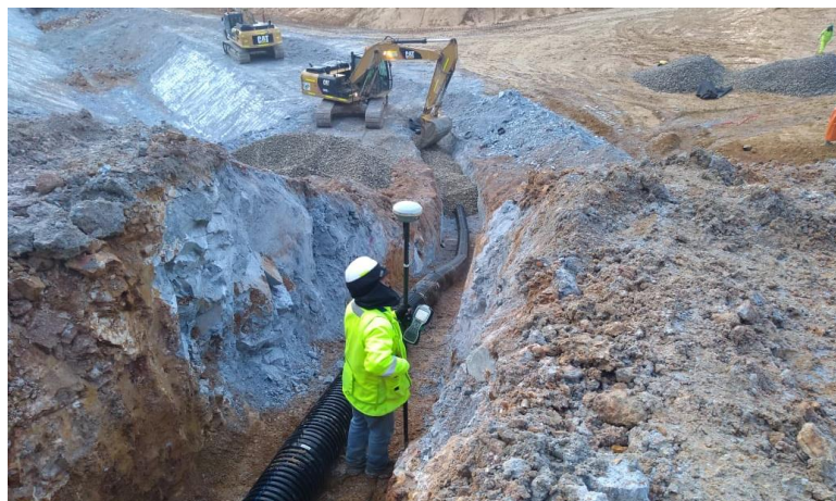
Foto 14. Levantamiento del sistema de subdrenaje, ramal 3 en el frente 5 del PAD, con equipo topográfico de alta precisión
