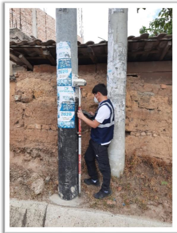
FOTO N°8. Levantamiento postes de luz
