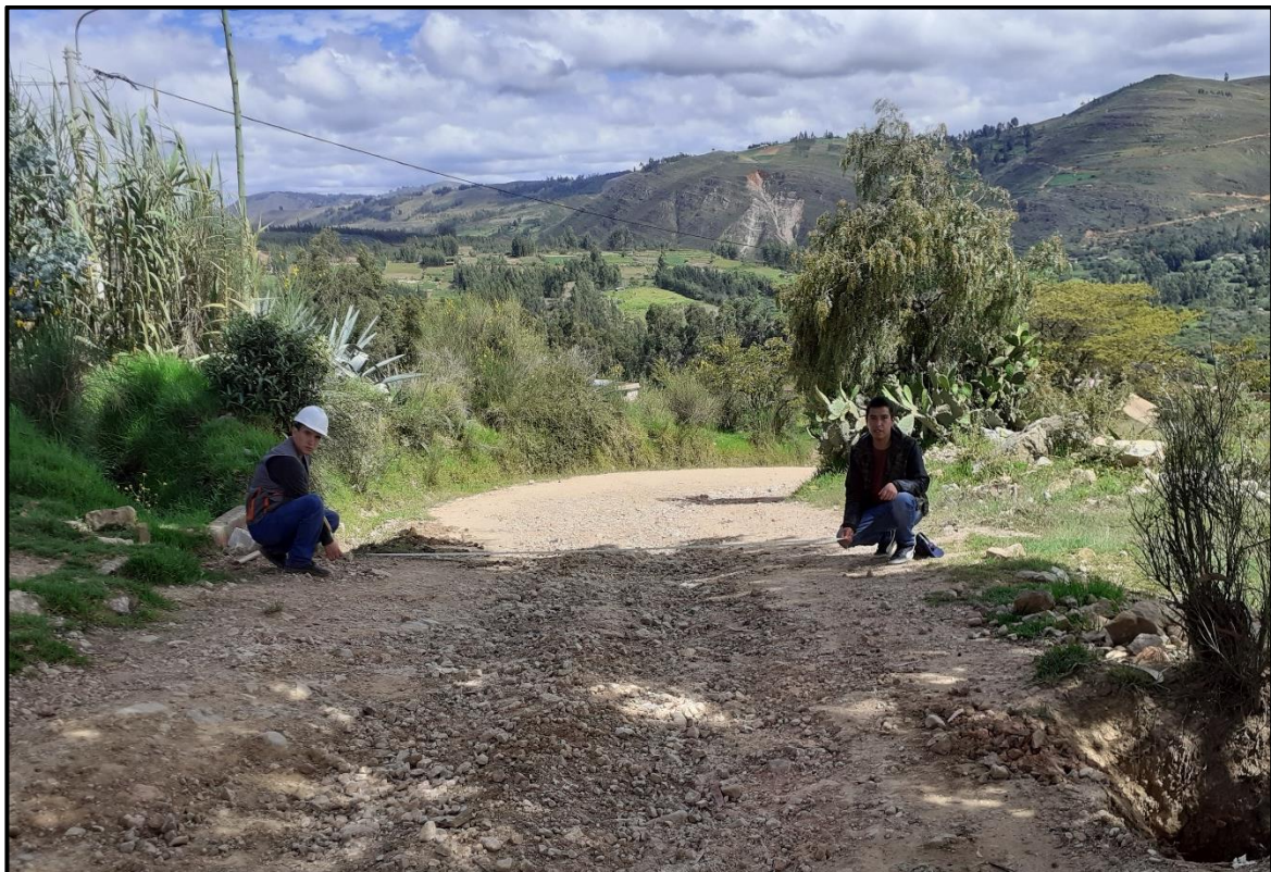
Foto A.12. Medición de ancho de la calzada en la progresiva km 00+400 (con cinta métrica de 50m).
