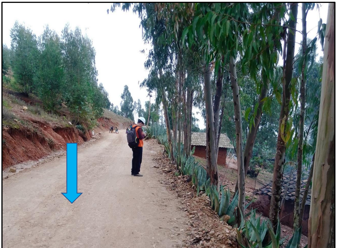
Foto A.8. Punto Final de la carretera Catan - Yuracmarca, Progresiva km 07+203.52
