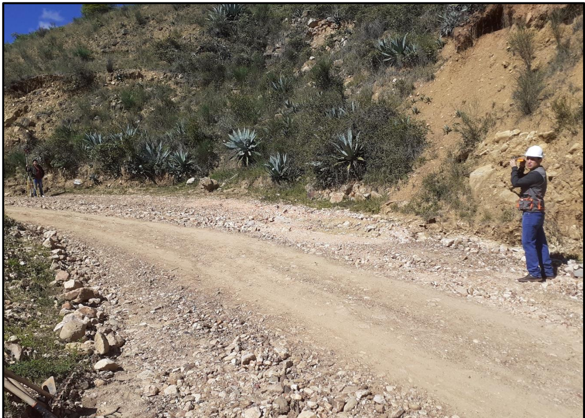
Foto A.18. Verificación de inclinación en pendientes de la vía, con el eclímetro.
