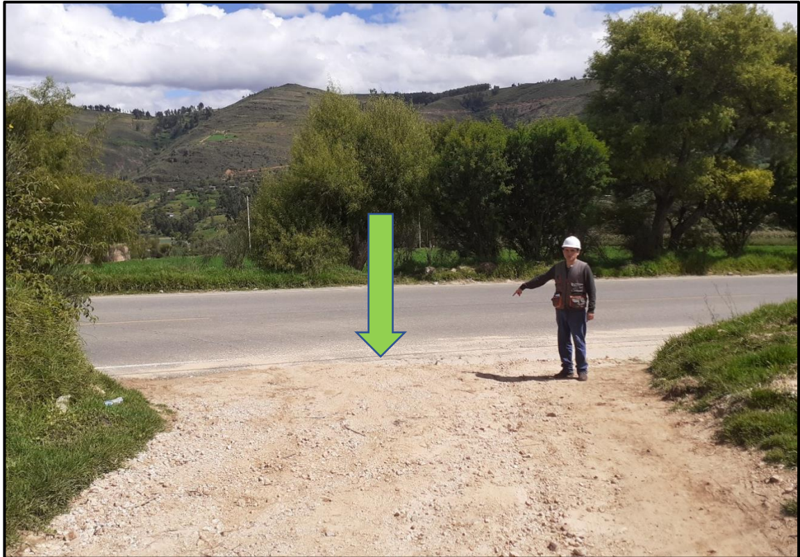
Foto A.7. Punto Inicial de la carretera Catan - Yuracmarca, Progresiva km 00+000.
