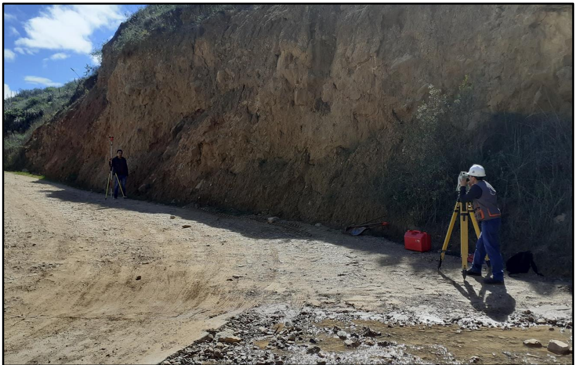
Foto A.14. Levantamiento topográfico en la curva n°12, progresiva 01+010.
