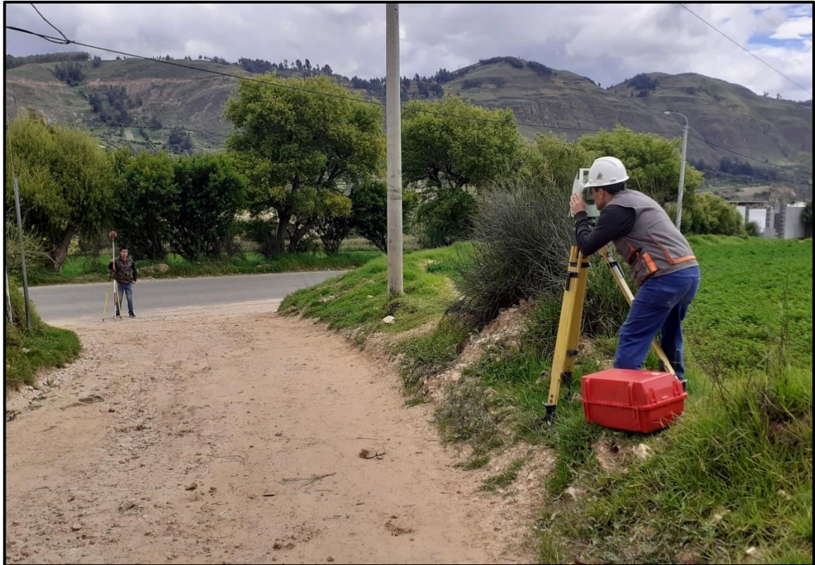
Foto A.9. Comenzando el Levantamiento topográfico del punto inicial, ubicado en el centro poblado Catan.
