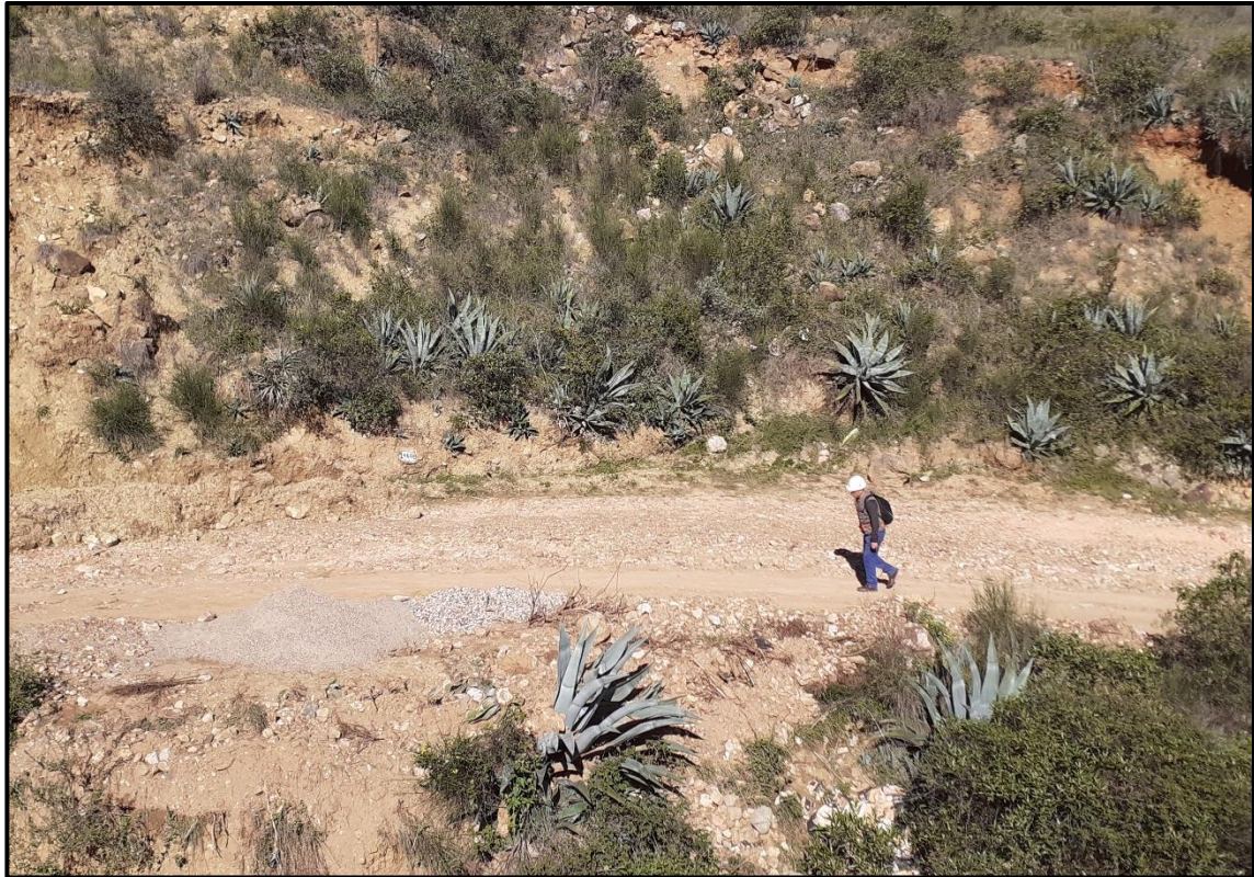
Foto A.5. Inspección general de la vía en estudio mediante el recorrido total de la carretera, observando de manera amplia la topografía y la situación actual de la vía.
