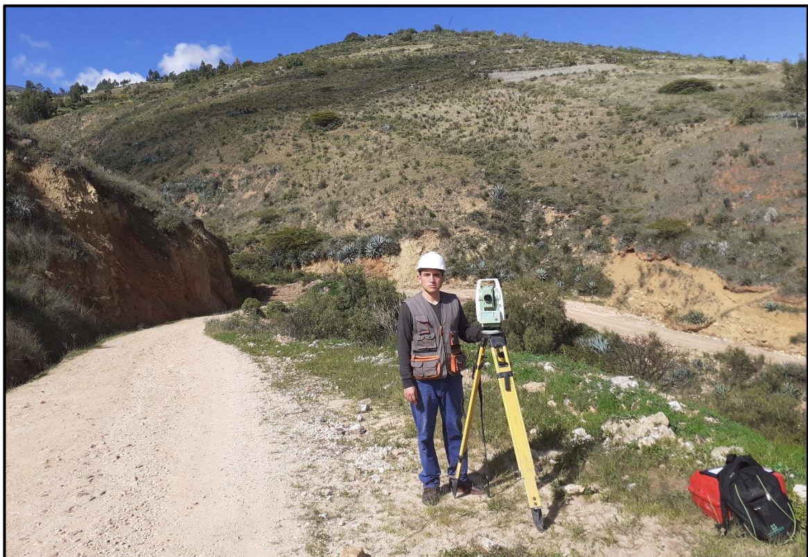
Foto A.10. Instalación de Estación Total en campo para la continuación del levantamiento topográfico de la carretera.
