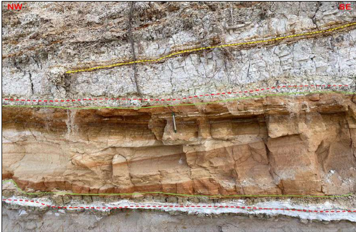
Figura 62. Afloramiento de la Formación Cajabamba en el corte de carretera su litología característica que presenta es las areniscas blanquecinas, lodolitas y arcillitas.
