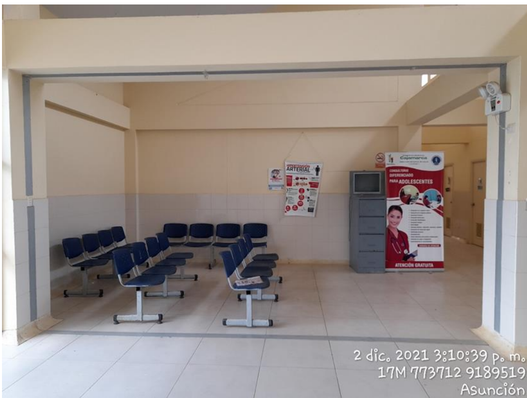
Figura 88: Junta sísmica en el módulo A.
