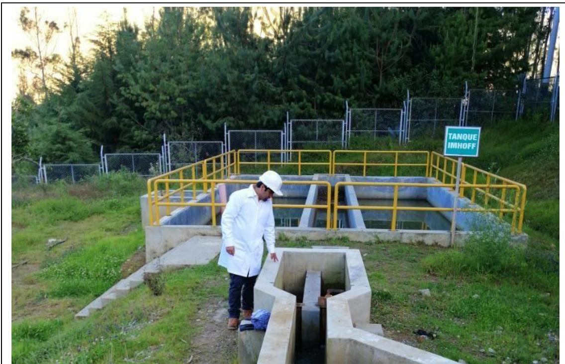
Fotografía N° 6: Inspección del desarenador del sistema de tratamientos de agua residual.
