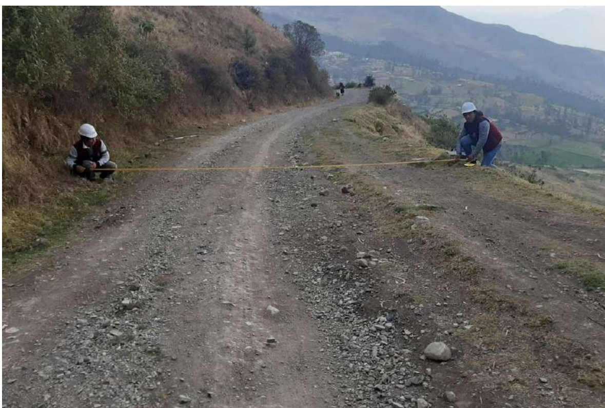
Fotografía N°10: Medición de ancho de plataforma.
