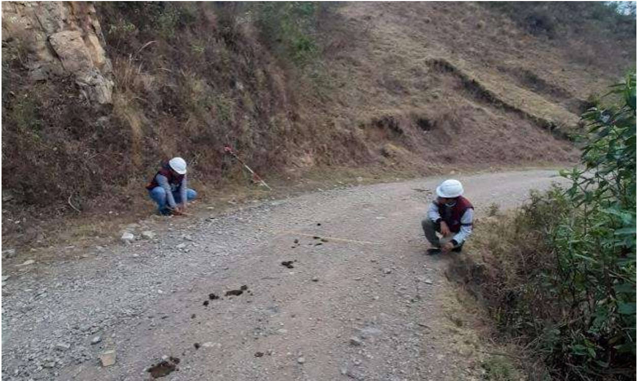
Fotografía N°07: Medición de ancho de calzada en curva, determinación de sobre ancho.
