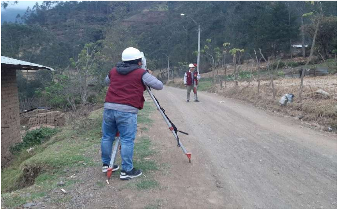
Fotografía N°03: Toma de puntos en el eje de la vía en estudio.
