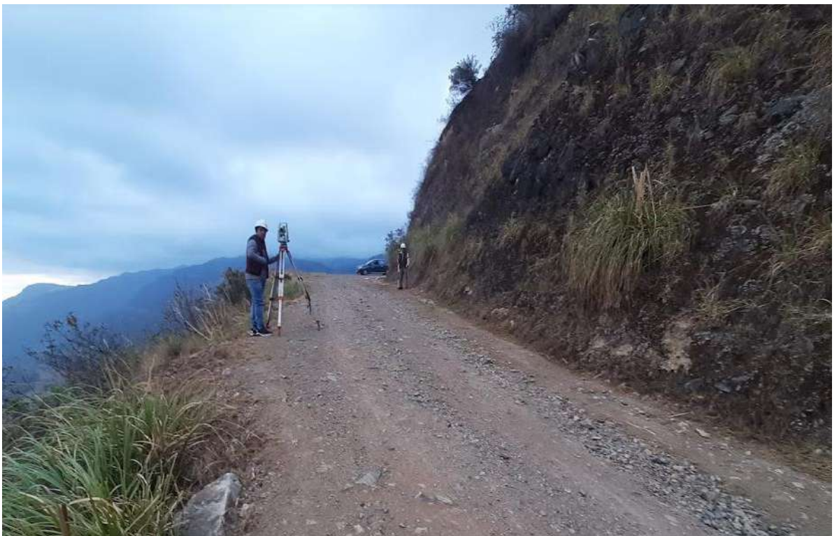
Fotografía N°14: Levantamiento topográfico en faja de rodadura.
