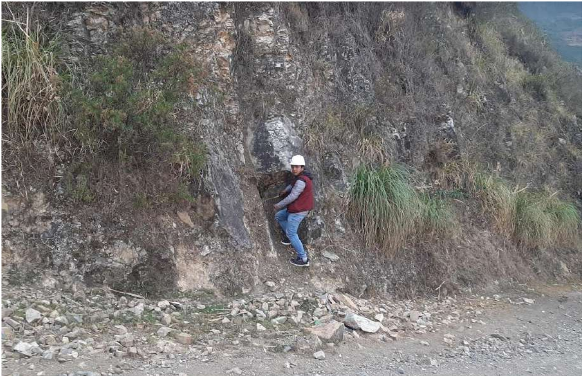
Fotografía N°12: Medición de inclinación del talud.
