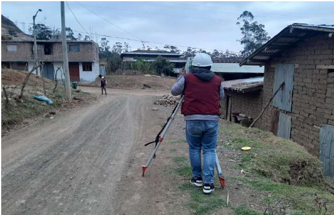
Fotografía N°01: Medición de ancho de calzada al inicio de la vía.
