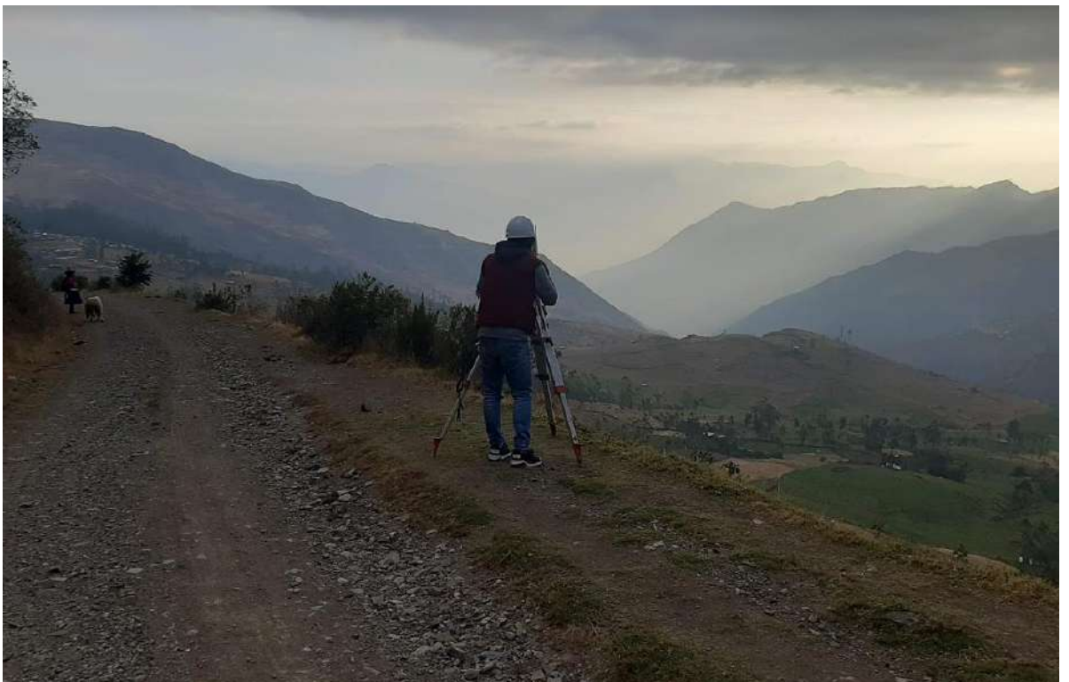
Fotografía N°18: Toma de puntos en el pie del terraplén.
