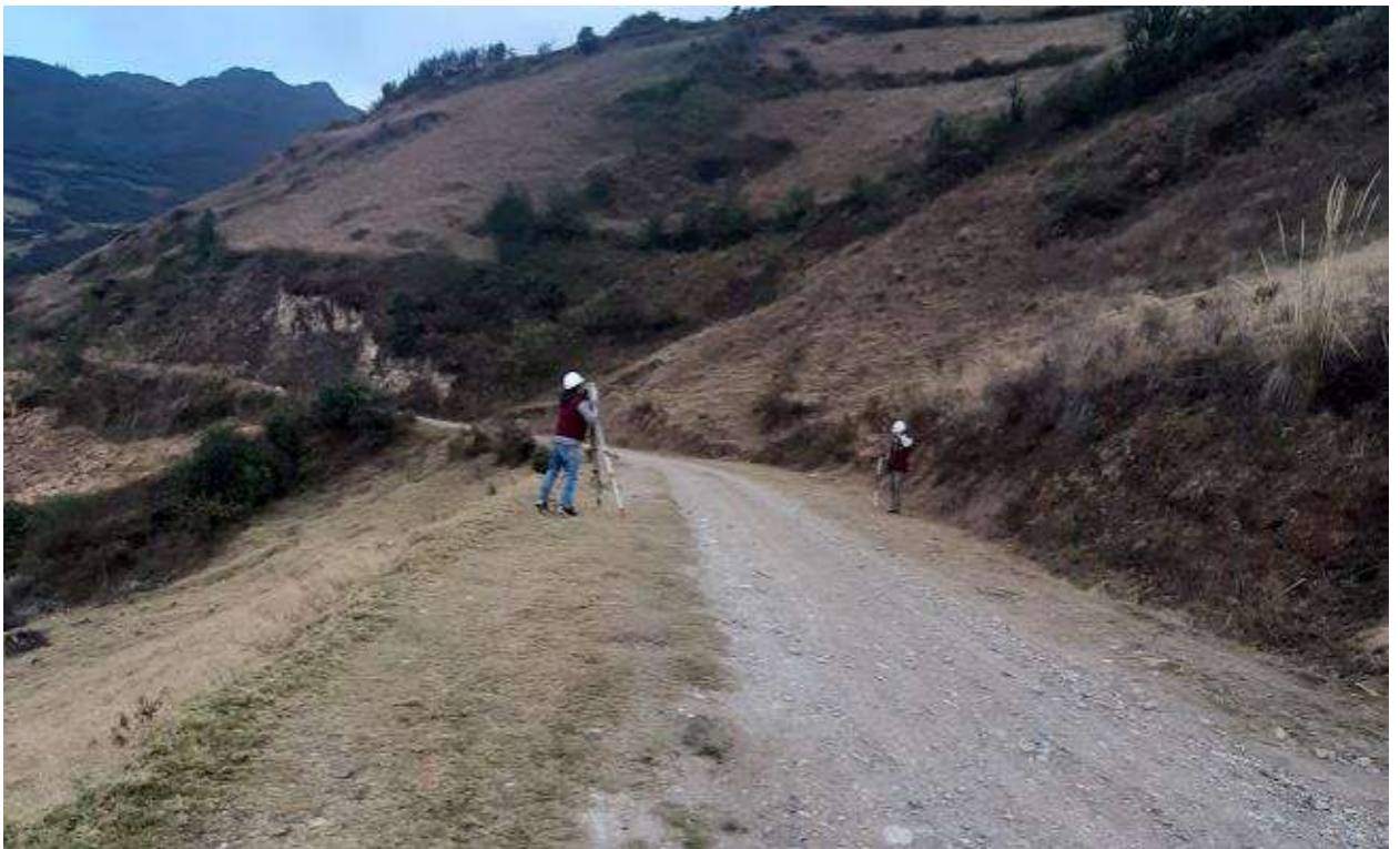
Fotografía N°06: Toma de puntos en la cuneta.
