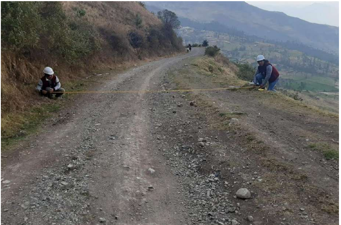
Fotografía N°10: Medición de ancho de plataforma.
