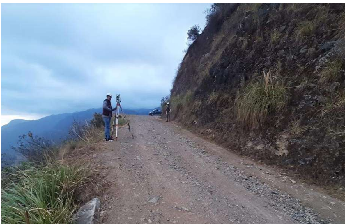
Fotografía N°14: Levantamiento topográfico en faja de rodadura.
