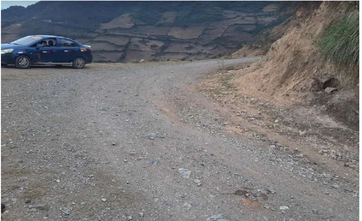
Fotografía N°17: Curva con visibilidad ineficiente.
