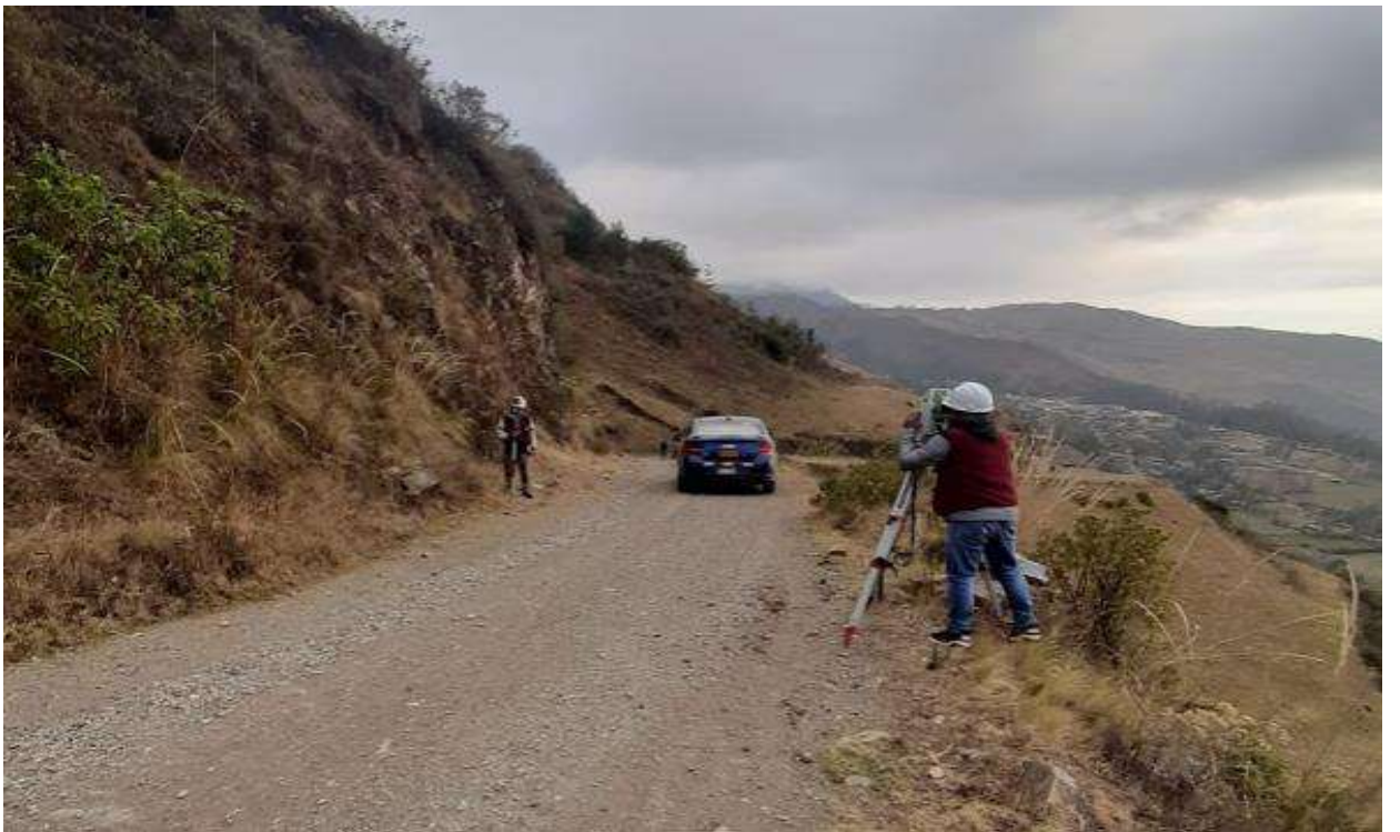
Fotografía N°08: Toma de puntos topográficos en el pie del talud de corte.
