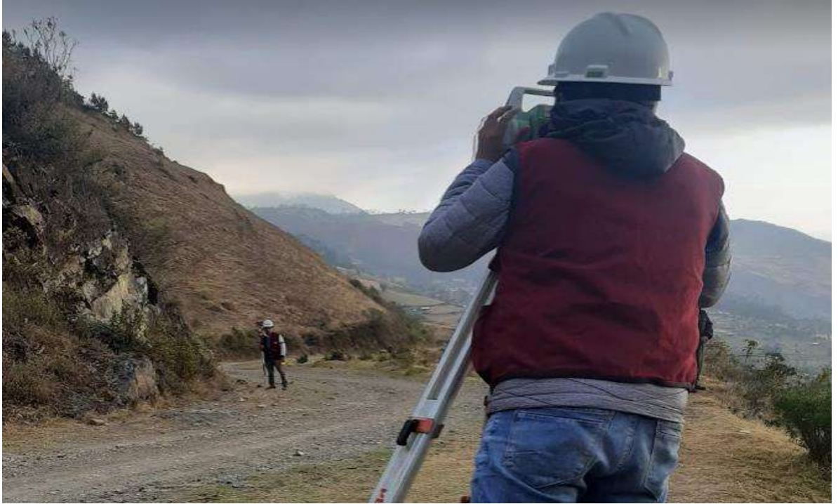
Fotografía N°11: Levantamiento topográfico de faja de la vía.
