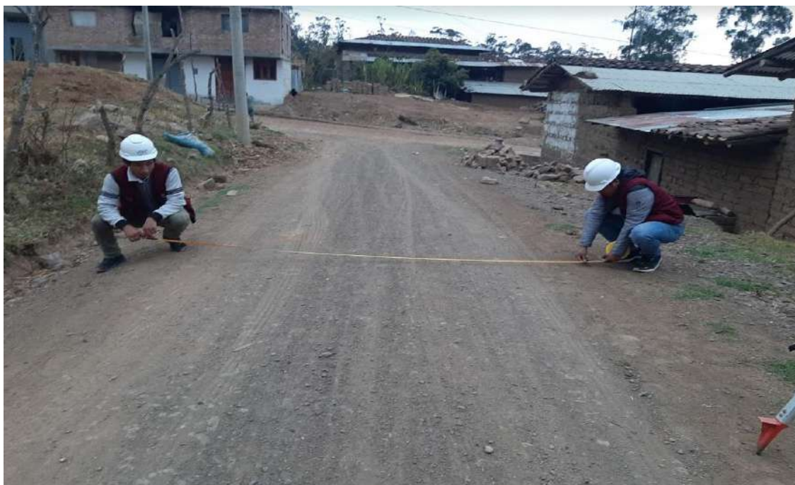
Fotografía N°01: Medición de ancho de calzada al inicio de la vía.
