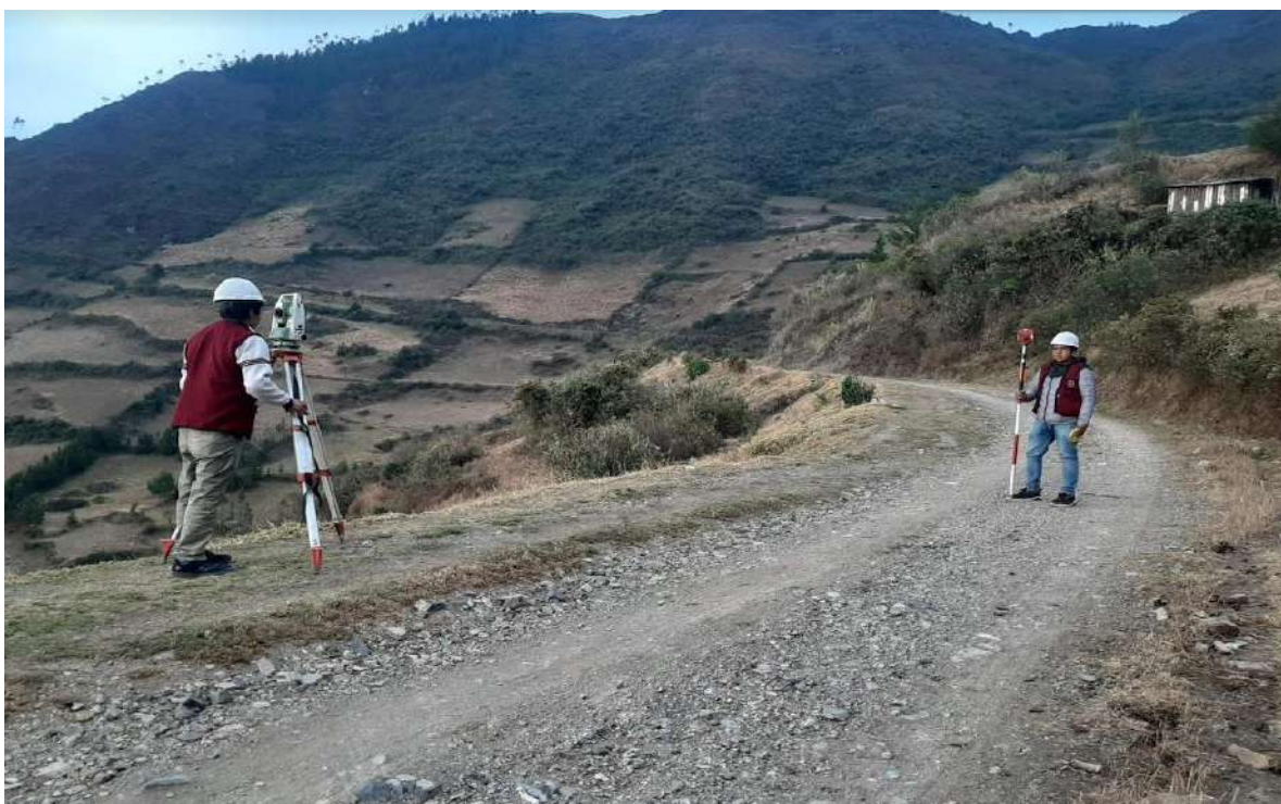
Fotografía N°09: Toma de puntos en eje y cálculo de pendiente con estación total.
