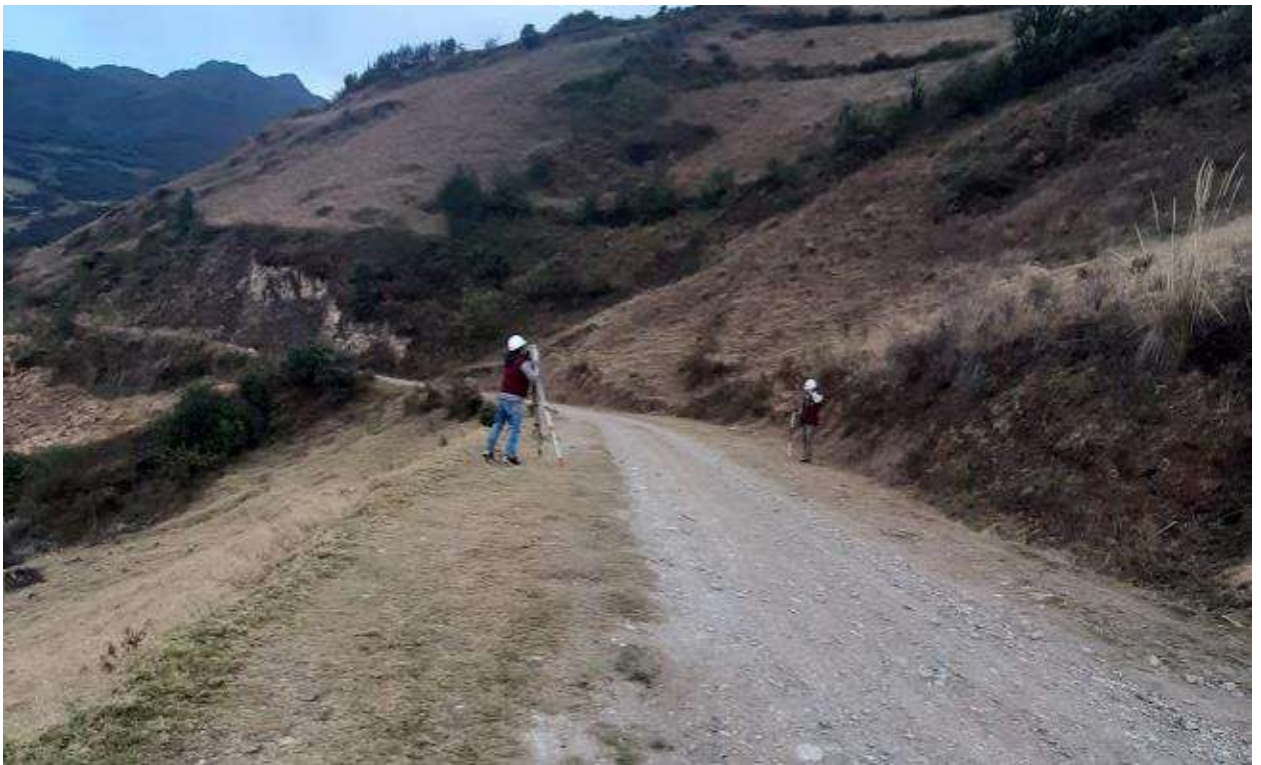
Fotografía N°06: Toma de puntos en la cuneta.
