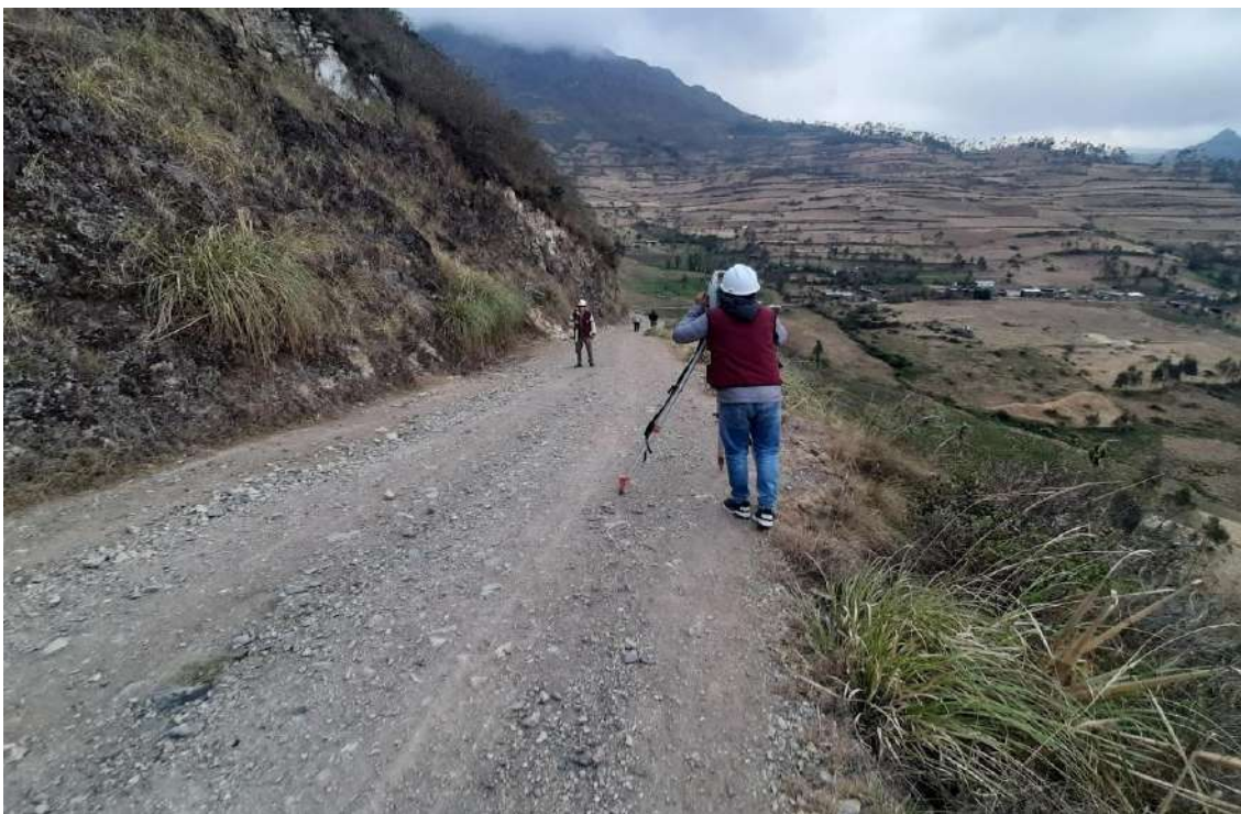
Fotografía N°04: Medición de pendiente con estación total.
