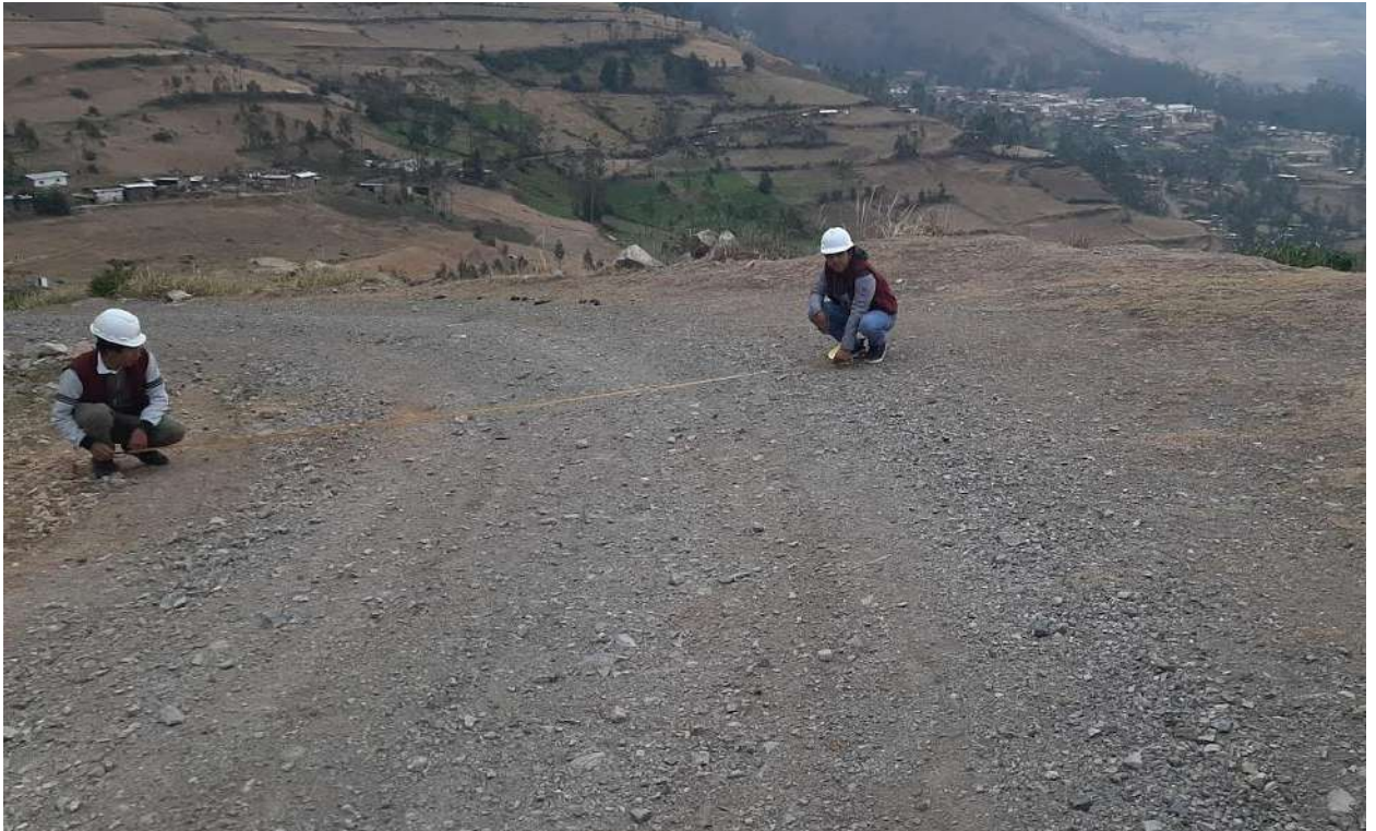
Fotografía N°05: Medición del ancho de plataforma en curva (determinación de peralte)
